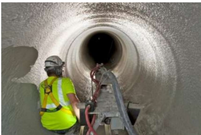
Figura 6- Tubos de esgoto reparados com spray de geopolímero.
