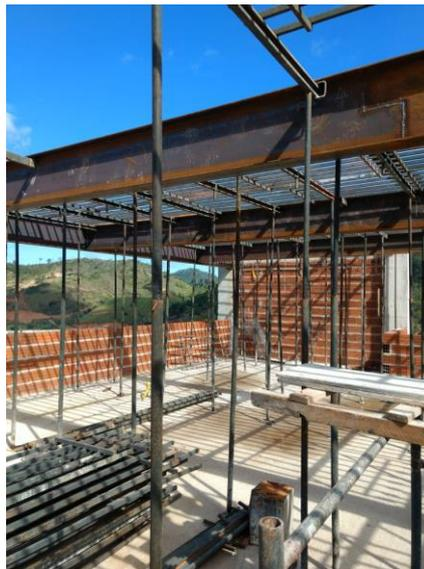
**Figura 3: Escoramento metálico da laje. Fonte: Elaborado pelos autores, 2019.**
