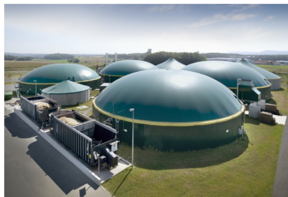
Figura 8 – (a) Modelo esquemático do reator CSTR; (b) Biodigestor CSTR.
