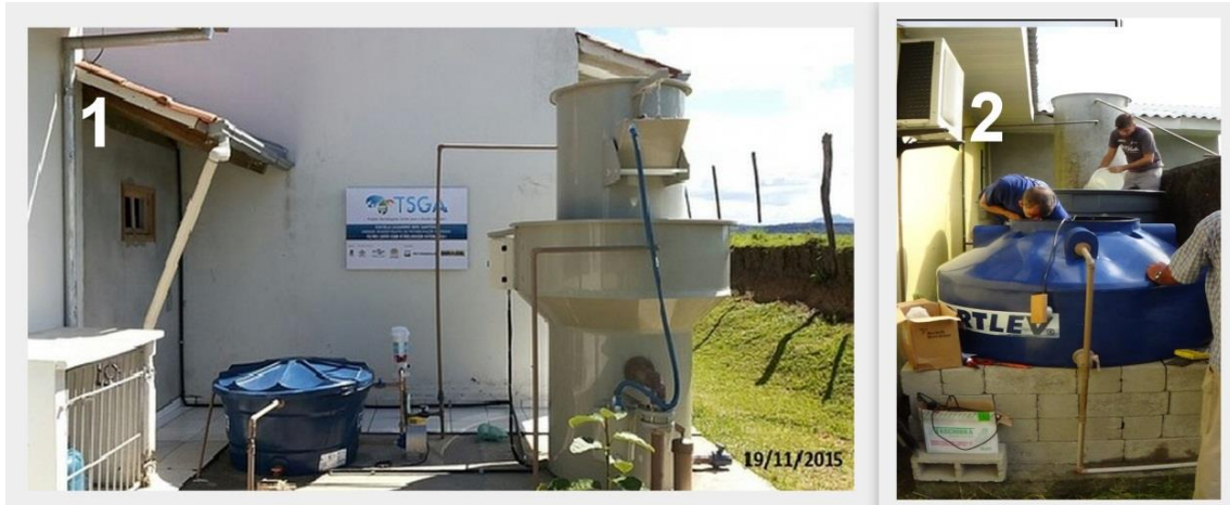
Figura 11. Unidades demonstrativas em saneamento básico rural - Filtro Lento. 1-Ituporanga/SC; 2-Urubuci/SC.
