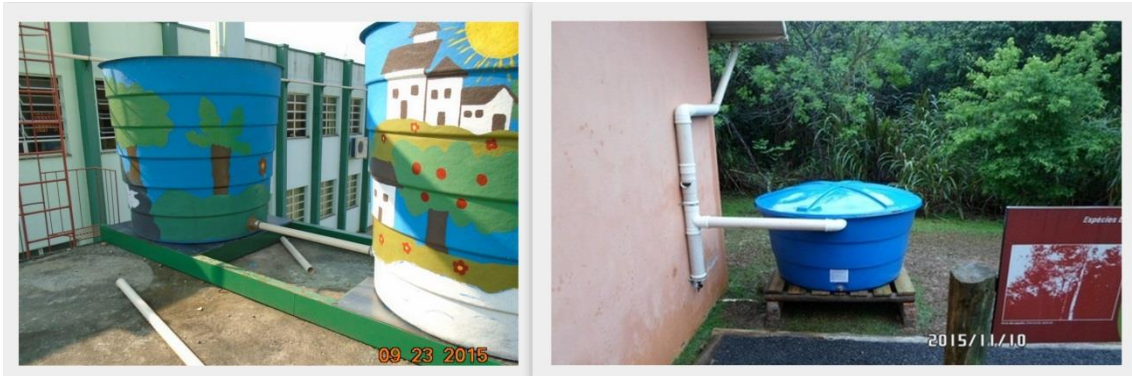
Figura 9. Unidades demonstrativas em captação e aproveitamento de água da chuva, cisternas convencionais, Braço do Norte/SC e Concórdia/SC.
