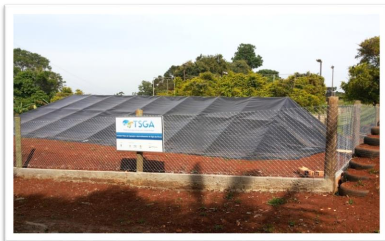
Figura 8. Unidade demonstrativa em captação e aproveitamento de água da chuva, cisterna modelo Coronel Freitas, Epagri, CETREC, Chapecó/SC
