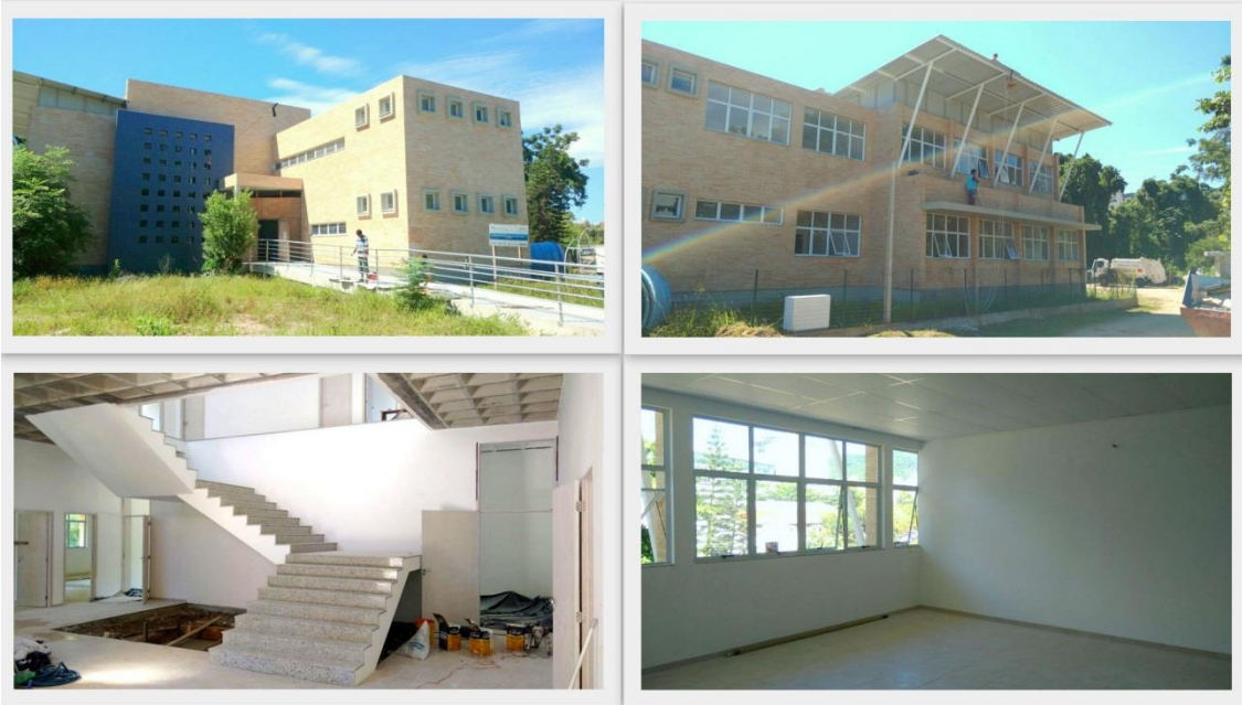
Figura 33. Fotos do prédio CETRAGUA: fachada e parte interna.
