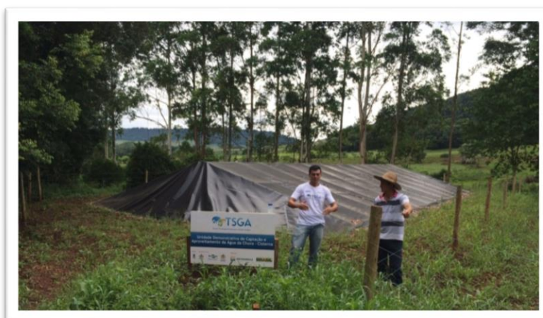
Figura 6. Implantação de sistema de captação e armazenamento de água integrada à irrigação de horta orgânica em propriedade agroecológica da família Luzzi em Chapecó/SC
