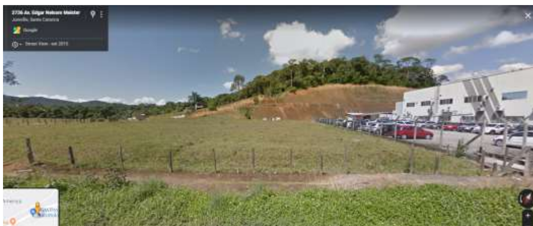
Figura 26 - Imagem geral do talude-tipo
