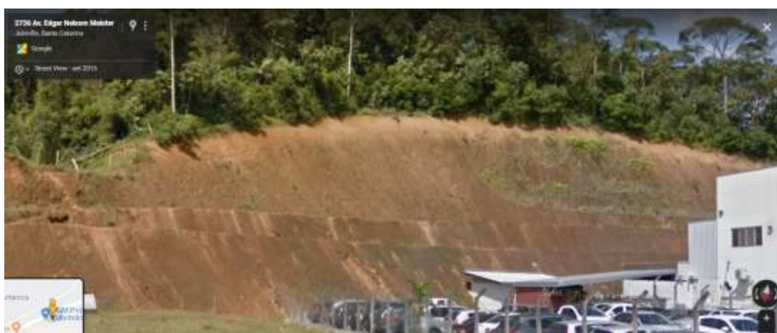
Figura 27 - Imagem aproximada do talude
