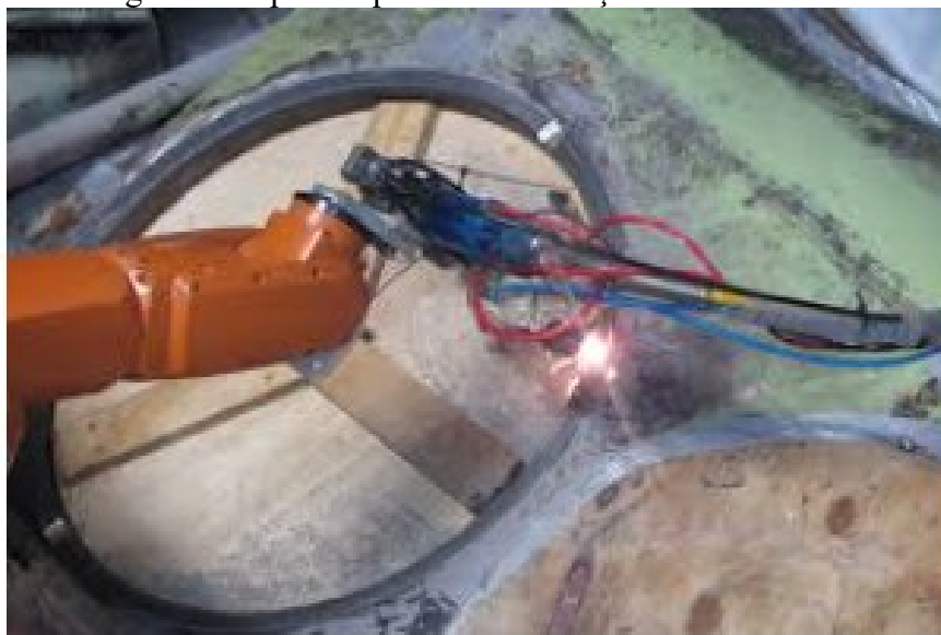
Figura 2: Reparo superfície de vedação de motor naval
