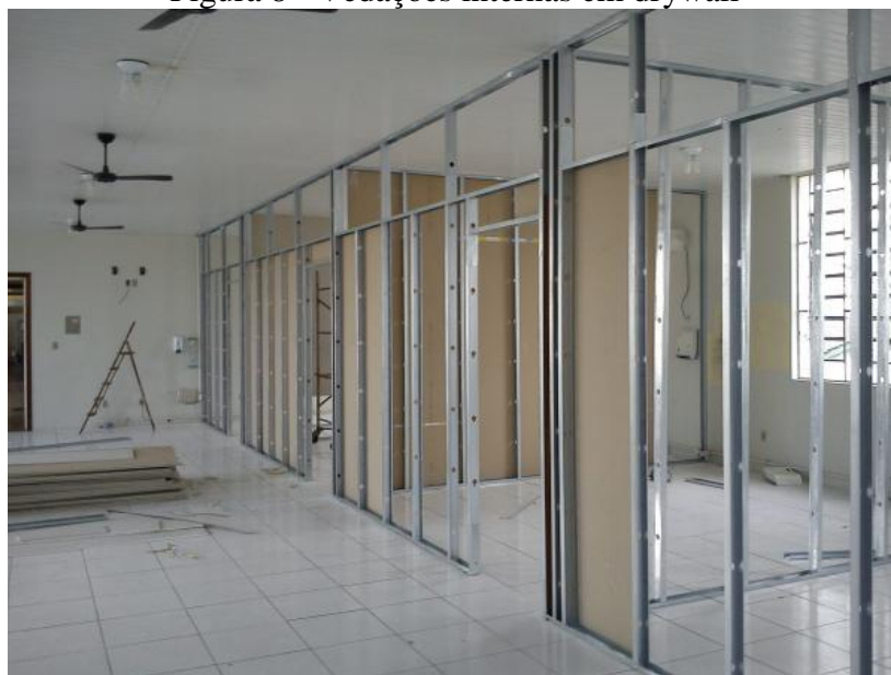
Figura 8 - Vedações internas em drywall
