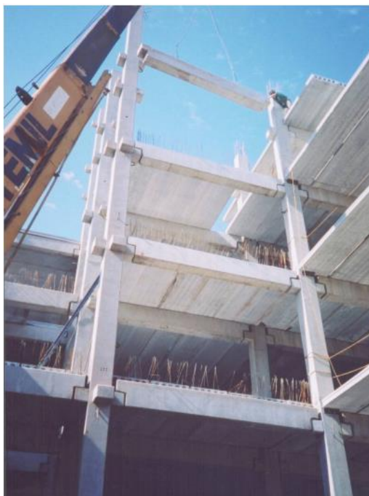
Figura 4 - Vista interior da uma obra com estruturas de concreto pré-moldado
