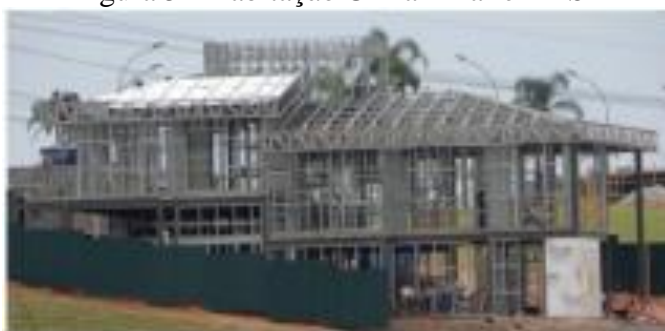
Figura 5 - Habitação Unifamiliar em LSF
