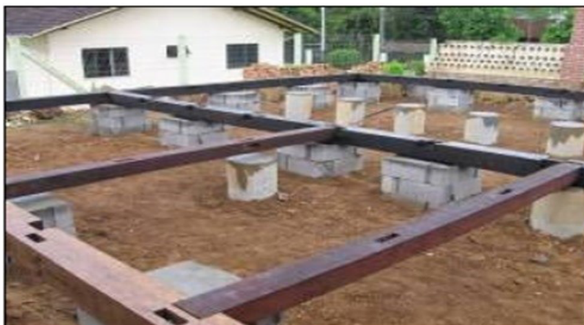
Figura 11: Os alicerces da construção Enxaimel
