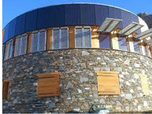
Figura 11: Painéis refletores integrados na estrutura do edifício. Fonte: Dualsun, 2015.
