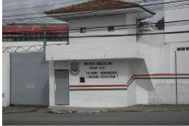
Figura 18 - Fachada do Presídio Masculino de Florianópolis
