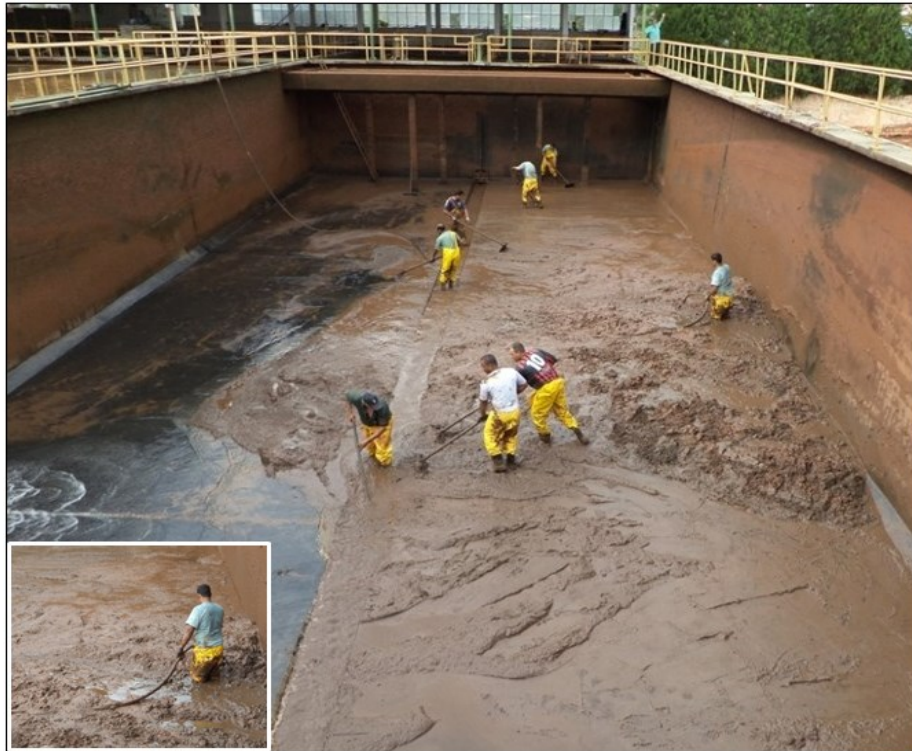
Figura 20 – Lavagem de decantador convencional horizontal.
