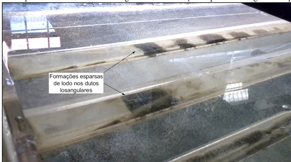
Figura 86 – Depósito de lodo nos dutos losangulares com formações esparsas ao longo do comprimento.
