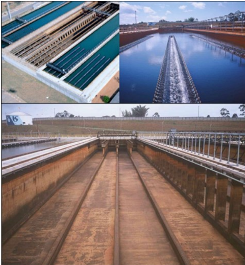
Figura 9 – Decantador convencional de escoamento horizontal.
