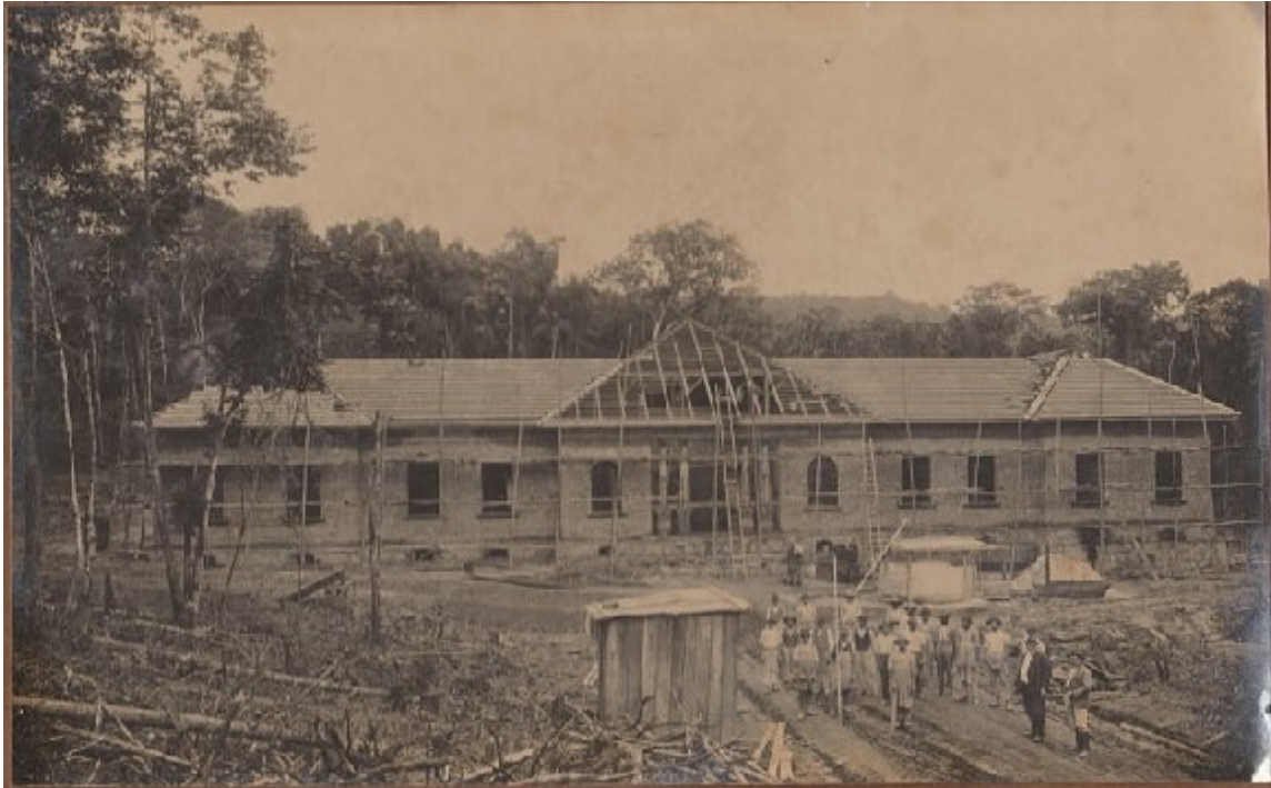
Figura 1 Construção do Abrigo de Alienados.
