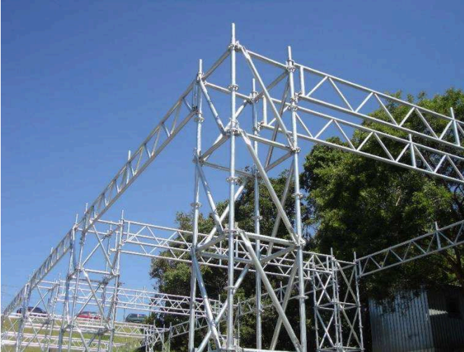
Figura 12 - Aplicação de tubos de pequeno diâmetro em andaimes.
