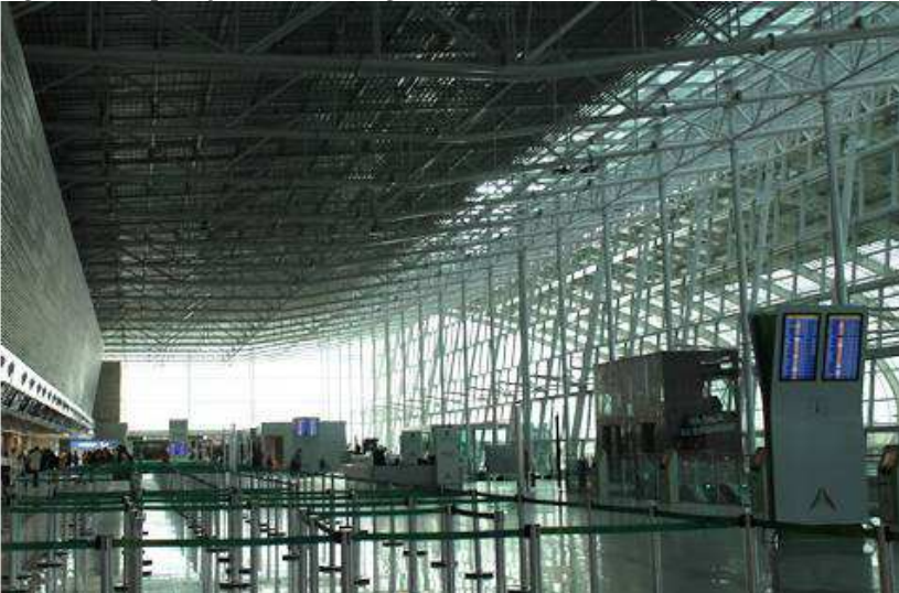
Figura 15 - Aplicação de tubos de grande diâmetro – Aeroporto de Natal (RN).
