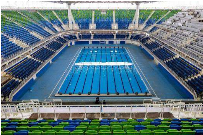
Figura 11 - Aplicação de tubos de pequeno diâmetro na construção civil – Estádio Aquático Olímpico.
