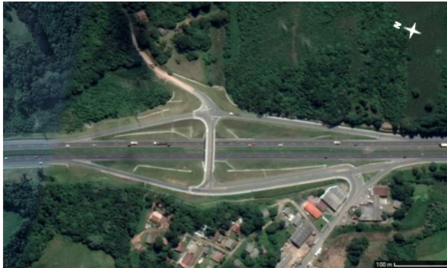
Figura 12 – Localização do Viaduto 1
