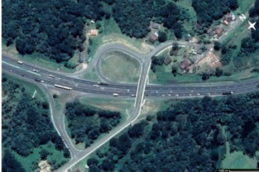
Figura 15 – Localização do Viaduto 2
