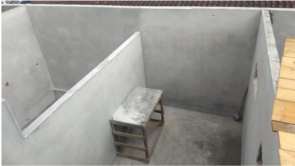
Figura 23 – Revestimento de argamassa finalizado no canteiro de obras
