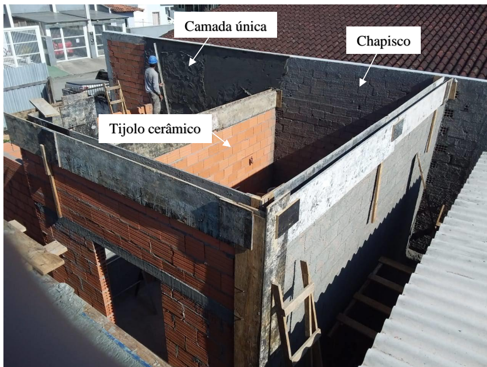
Figura 22 – Execução do revestimento de argamassa no canteiro de obras
