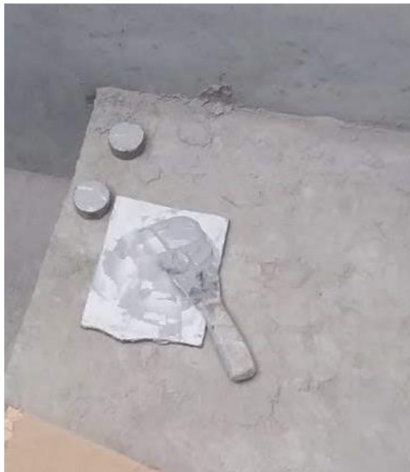
Figura 26 – Pastilhas metálicas circulares com resina epóxi
