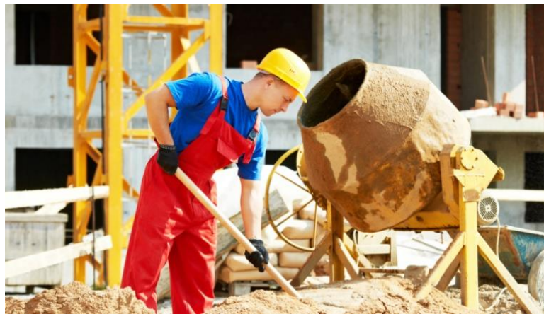
Figura 6 – Preparação da argamassa rodada em obra pela mão de obra
