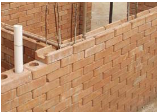
Fig.13a e b – Instalações hidráulicas e fiada com blocos canaleta.
