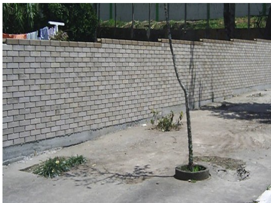
Fig.8 a – Muro com sistema trava-bloco
