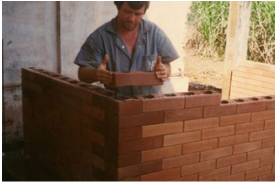
Fig.10a – Demonstração de encaixe do bloco. b – Exemplo de fiadas linear e perpendicular.
