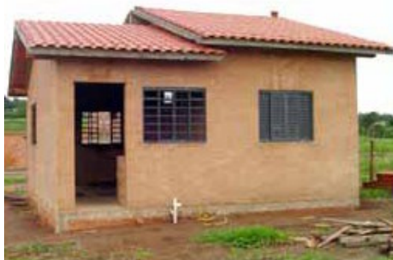
b-Unidade residencial construída com trava-blocos
