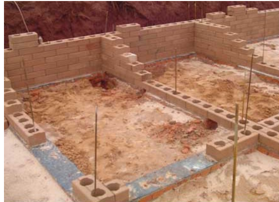
b – Primeiras fiadas sobre viga baldrame.
