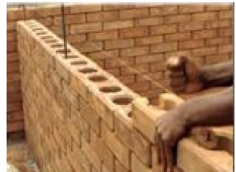
b - Sobreposição de blocos tipo canaleta
