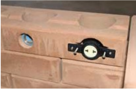
Fig.14a – Instalação elétrica.
