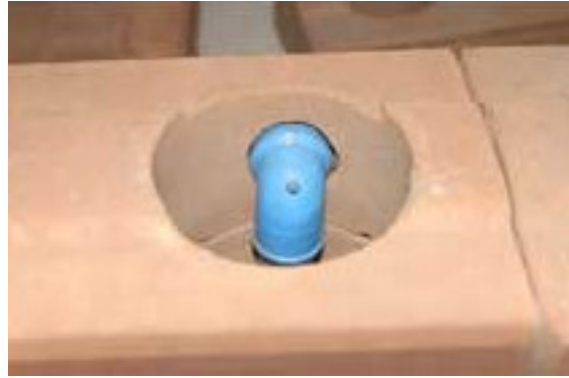
b – Instalação hidráulica.
