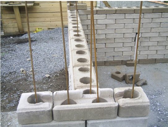
Fig.12a – Armaduras de espera.
