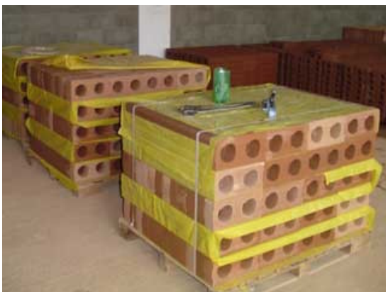
Fig.6 a – Armazenagem de blocos vazados.
