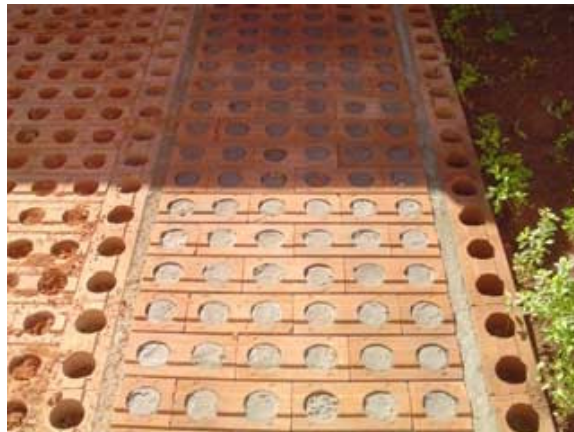
b Passeio construído com trava-blocos.
