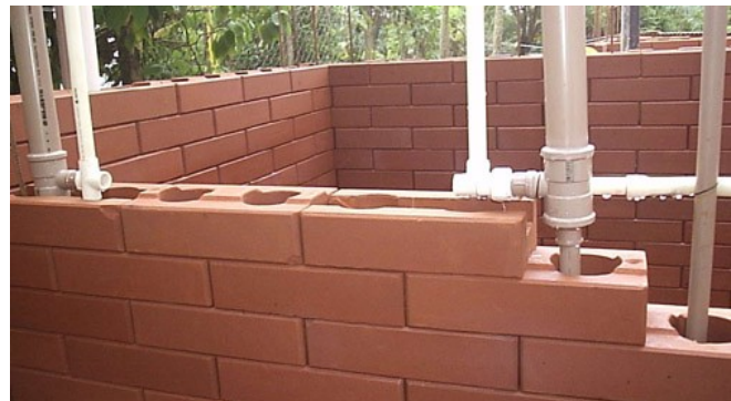
Fig.13a e b – Instalações hidráulicas e fiada com blocos canaleta.
