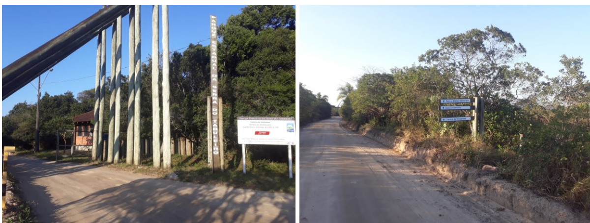
Figura 38 – Portal de entrada do CV e estrada de acesso ao estacionamento.
