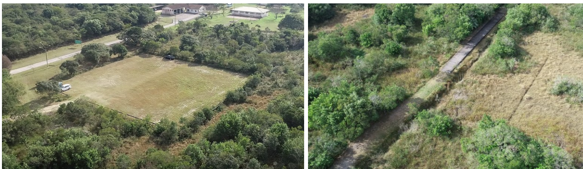
Figura 57 – Estacionamento e caminho até a sede.
