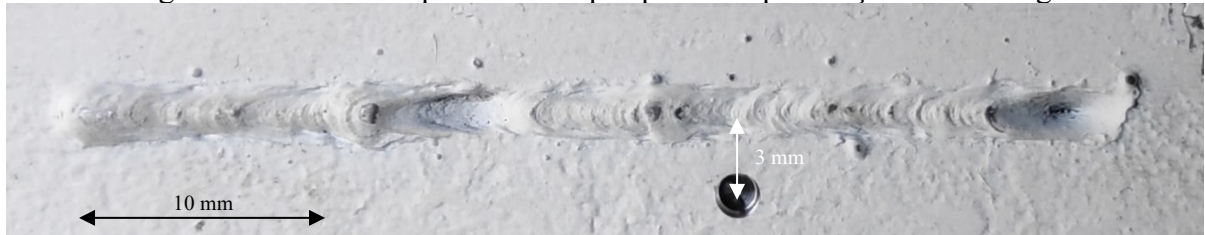
Figura 66 - Vista de topo da solda após pintura e perfuração do furo cego.
