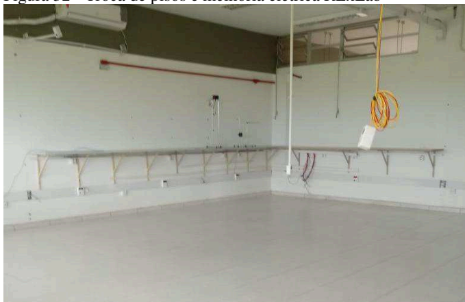
Figura 32 - Troca de pisos e melhoria elétrica RExLab
