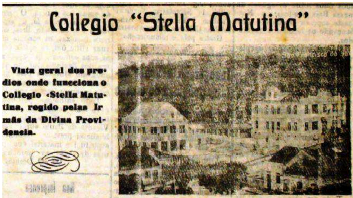
Figura 8 - Imagem dos Prédios do Colégio Stella Matutina Fonte – Hemeroteca da Biblioteca do Estado de Santa Catarina
