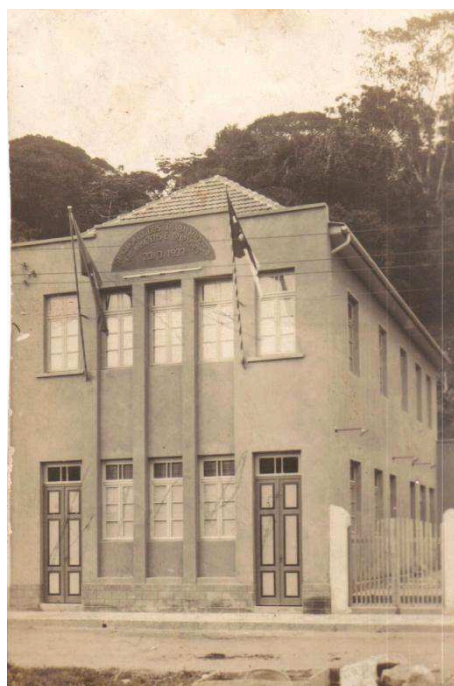
Figura 36 – Prédio do Sindicato dos Trabalhadores em Armazéns e Trapiches em 1937 Fonte: Biblioteca Pública Augusto José Ribeiro – São Francisco do Sul
