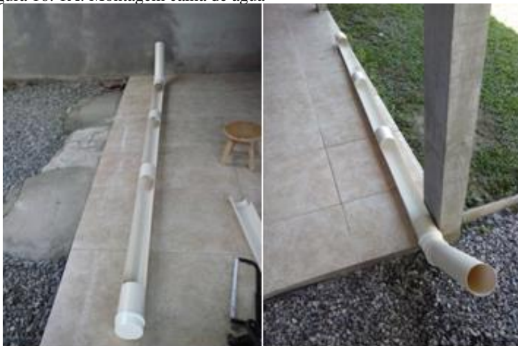
Figura 16: 1A: Montagem calha de água
