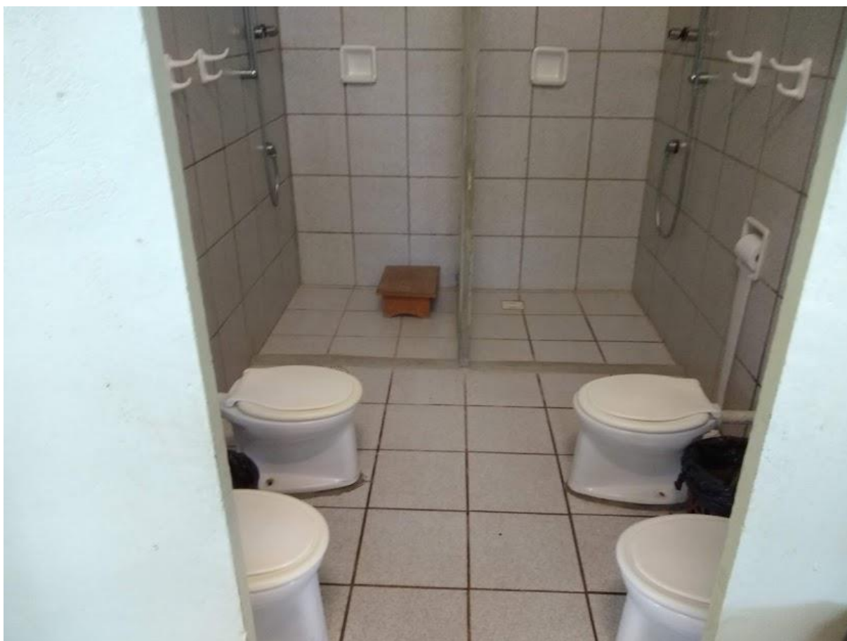
Figura 9 - Banheiro compartilhado. Fonte: Acervo pessoal.
