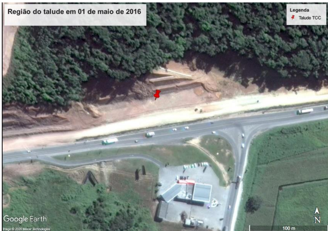
Figura 27: Primeiro registro de imagem de satélite após a construção do talude – maio de 2016.
