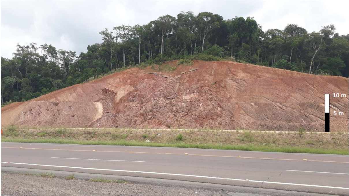
Figura 29: Visão geral do talude.
