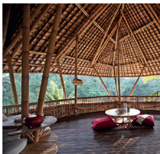
Estrutura construída com bambu.
