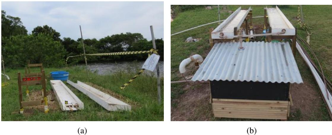
Figura 9 – Fotos do processo e itens construídos para o ATS. Em (a), manufatura e posicionamento dos cavaletes para apoio das rampas de fibra de vidro, e em (b) a casa da bomba. Fotos da autora.
