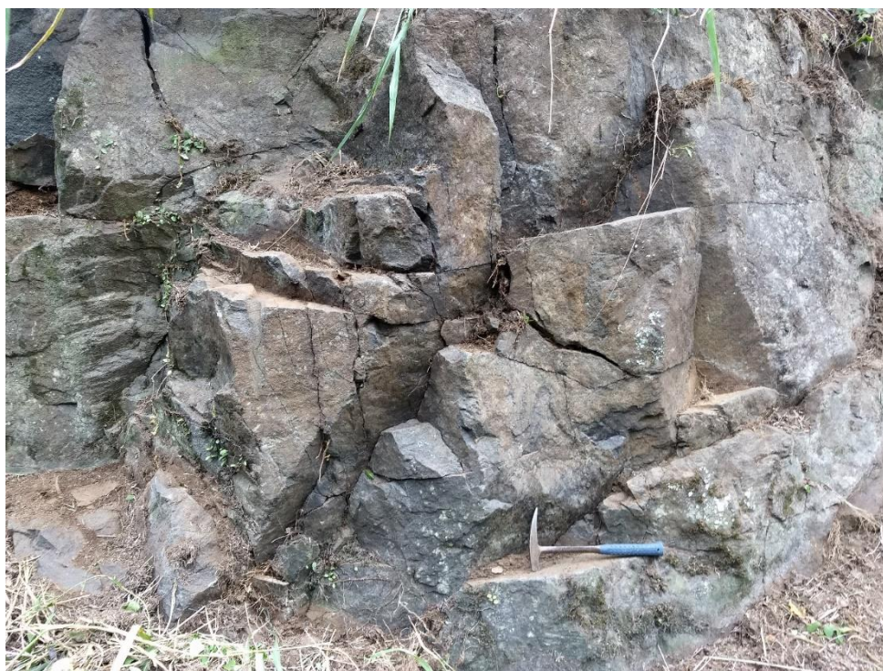
Figura 2 - Dique básico fraturado.
