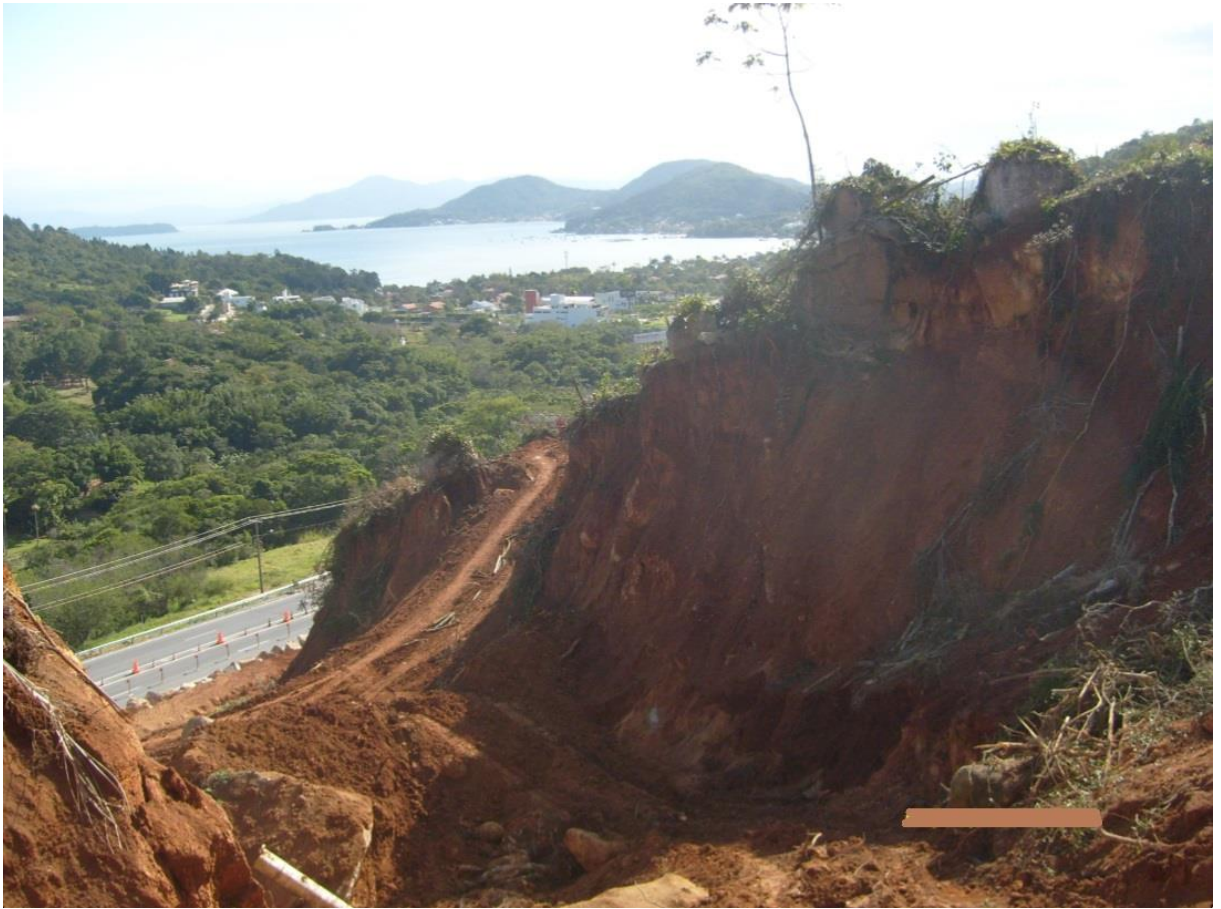
Figura 33 - Imagem pós-escorregamento mostrando a camada espessa de solo deslocada.
