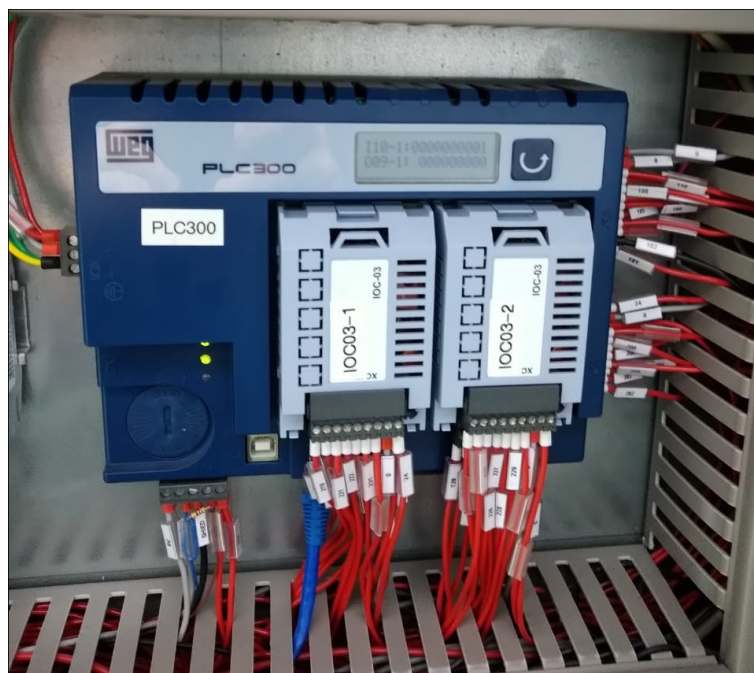
Figura 30 – PLC300 utilizado no sistema de automação do ensaio de relação de transformação.
