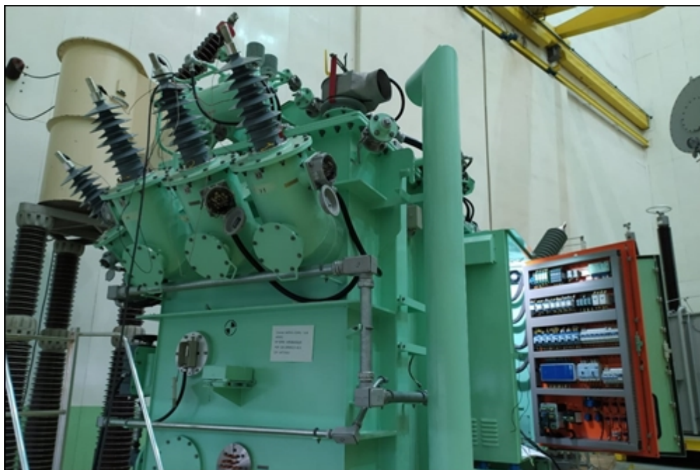
Figura 46 – Transformador WEG utilizado para validação do sistema de medição.
