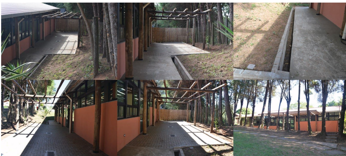
Figura 2: Visita técnica ao local. Fonte: elaborado pelos autores.
