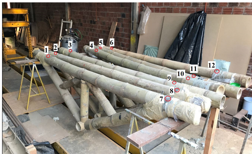
Figura 4: Concretagem dos apoios das tesouras. Fonte: autores.
