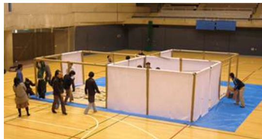
Figura 1.b: Abrigo já estruturado. Fonte: Shigeru Ban Architecture (2005).
