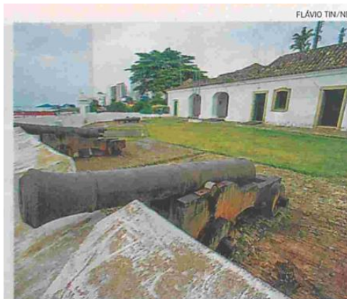
Forte Santana do Estreito já começou a ser reformado
