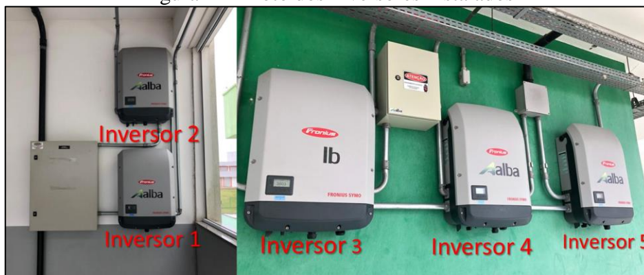
Figura 11 – Foto dos inversores instalados
