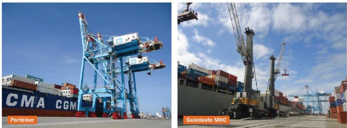
Figura 8- Guindastes da APM Terminals no Porto de Itajaí
