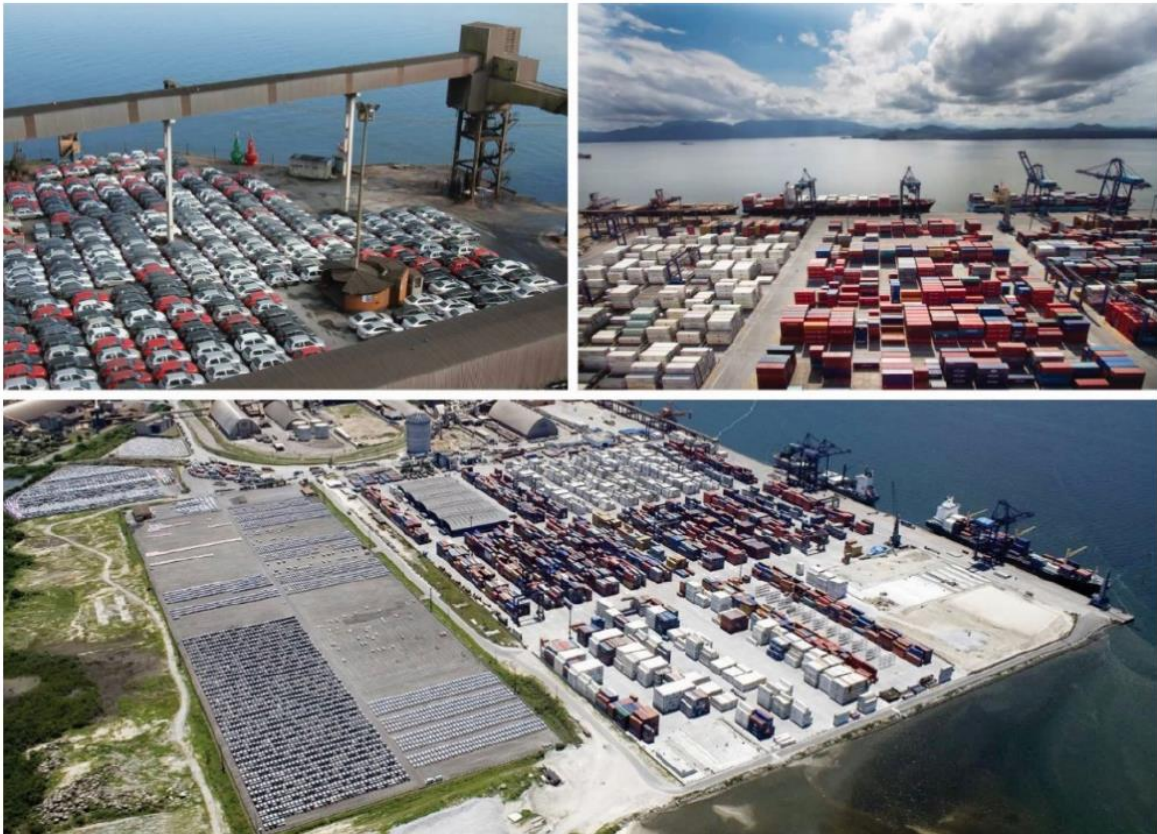
Figura 6 - Pátios no Porto de Paranaguá
