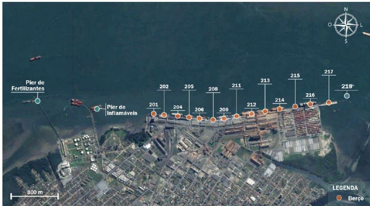
Figura 5 - Berços de Paranaguá em cais contínuo e píeres com dolphins
