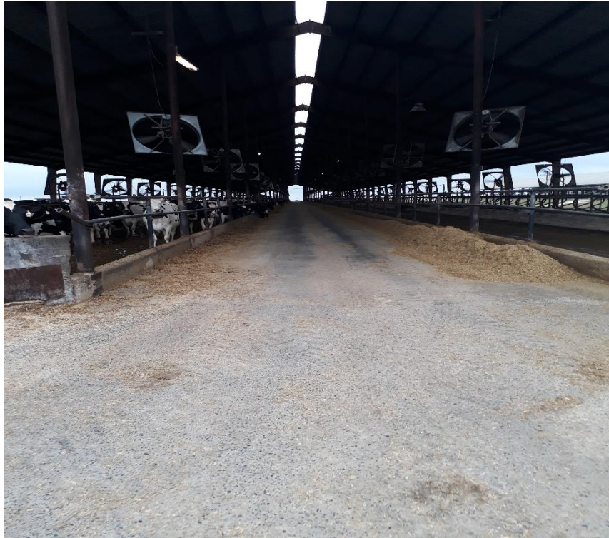
Figura 10 - Estrutura dos Galpões.
