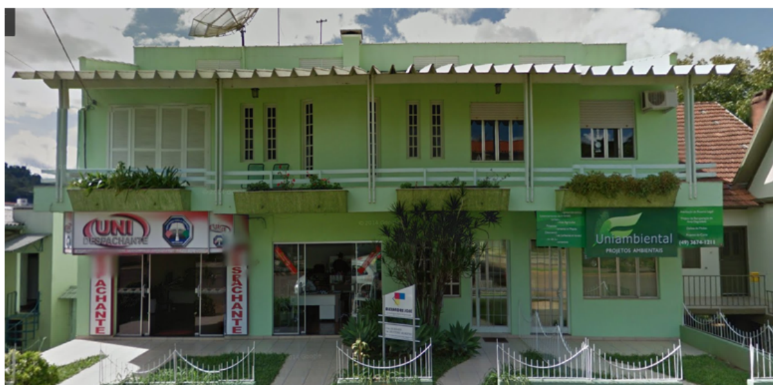
Figura 35 – Vista frontal da residência e do telhado onde o sistema será instalado. Fonte: Autor
