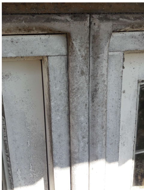
Figura 105 - Aspecto do acabamento externo em janelas maxim-ar na fachada frontal
