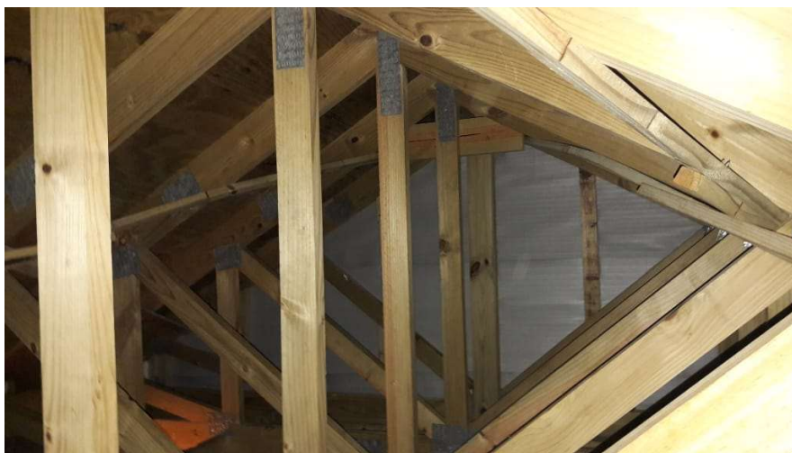
Figura 130 - Região interna do telhado do pavimento superior
