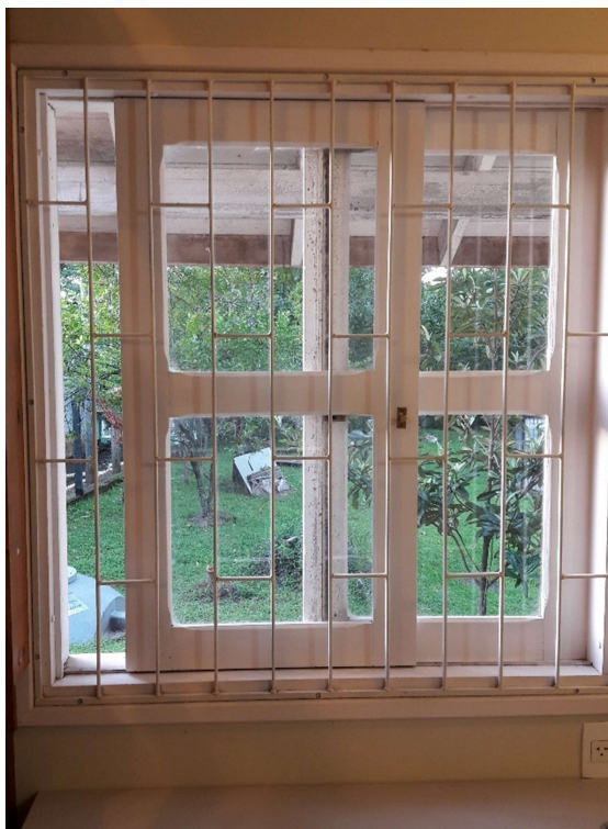
Figura 107 - Janela entre a sala de estar e a varanda
