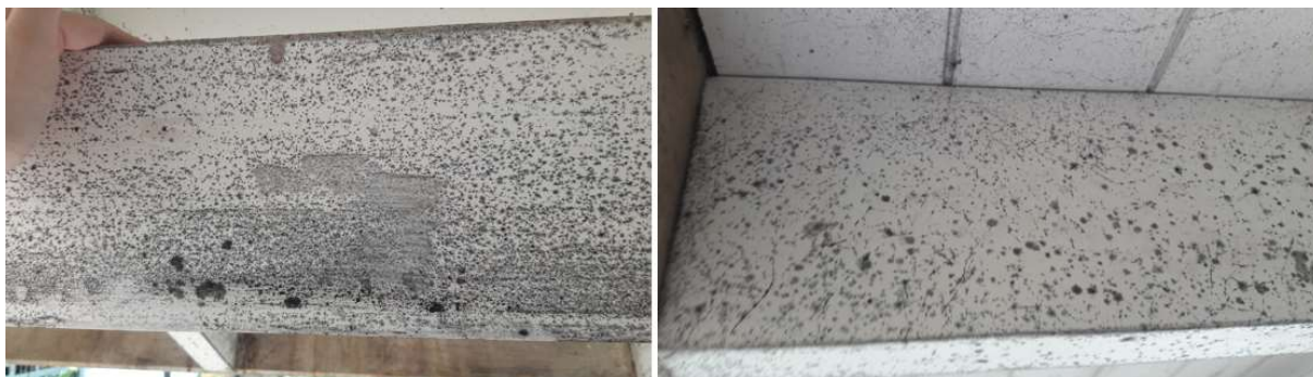
Figura 75 - Superfície das vigas analisadas antes do processo de investigação das manchas
