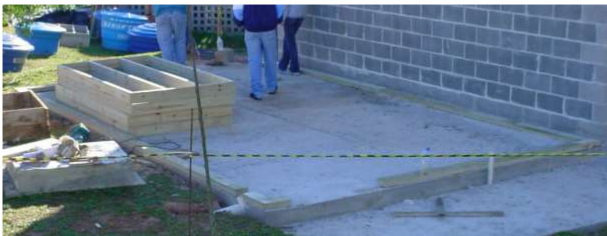
Figura 42 - Radier da edificação concretado
