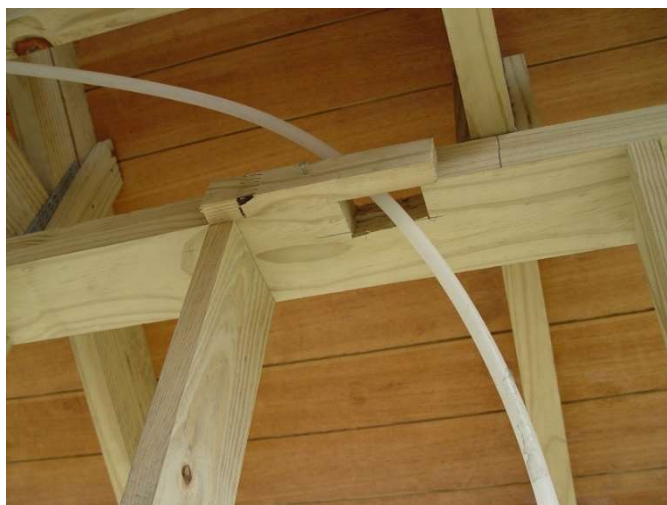
Figura 51 - Tubo PEX passando em meio à estrutura de madeira
