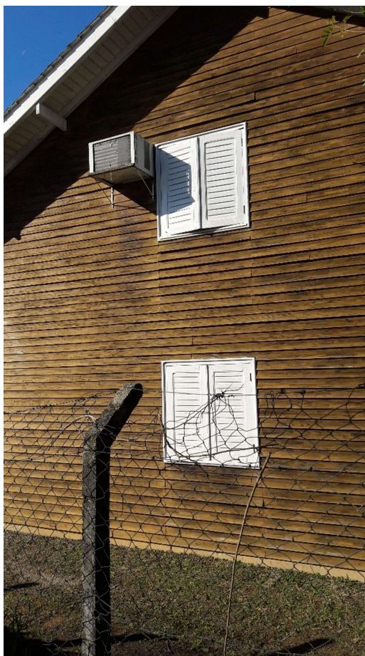
Figura 57 - Fachada lateral da edificação
