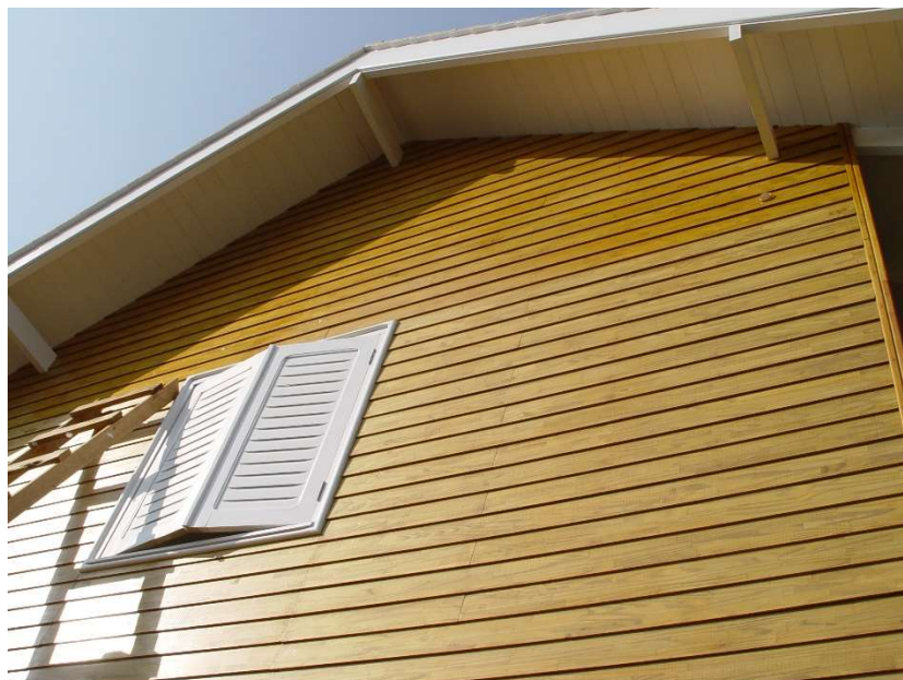
Figura 58 - Região da fachada lateral no momento da construção
