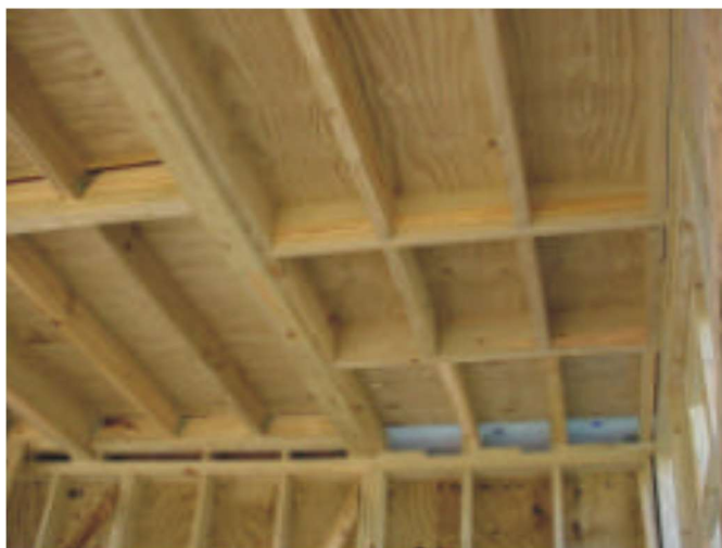
Figura 47 - Estrutura do Entrepiso do Banheiro
