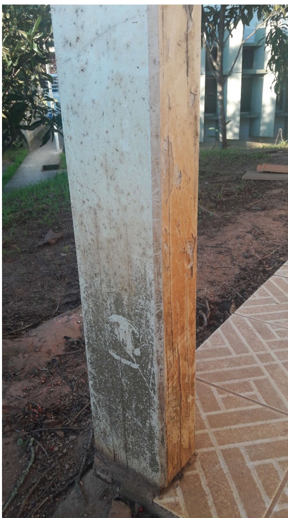
Figura 79 - Pilar presente na fachada frontal
