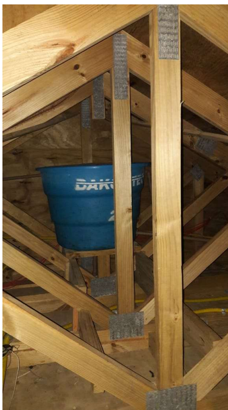
Figura 131 - Ambiente interno do telhado do pavimento superior
