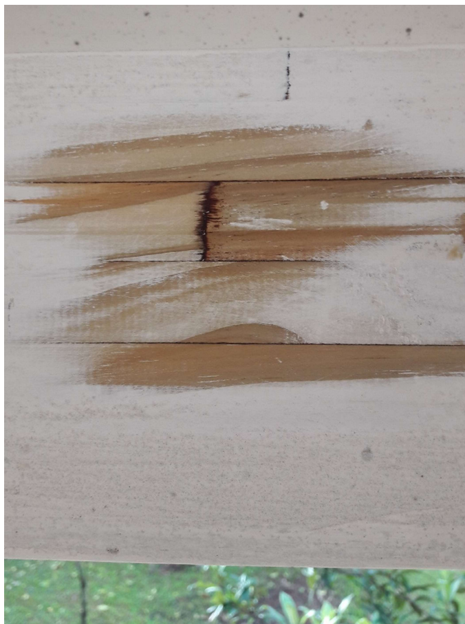
Figura 78 - Superfície de madeira da viga da fachada frontal após intensa lixação
