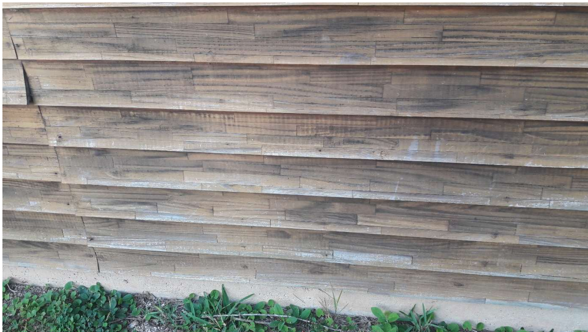
Figura 67 - Sidings com aspecto acinzentado
