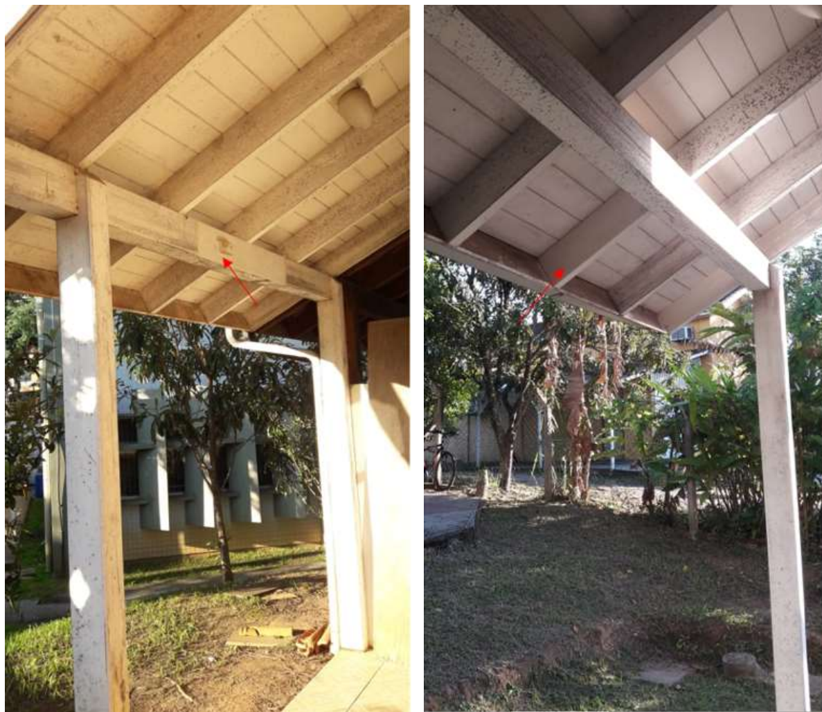
Figura 74 - Localização das regiões analisadas nas duas vigas da fachada frontal (a) e fachada traseira (b)
