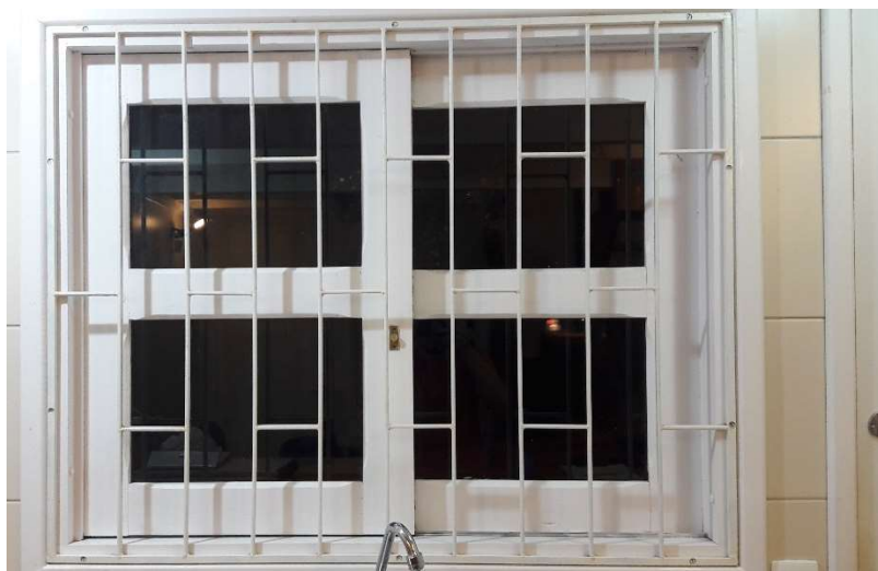
Figura 108 - Janela entre a cozinha e a área de serviço
