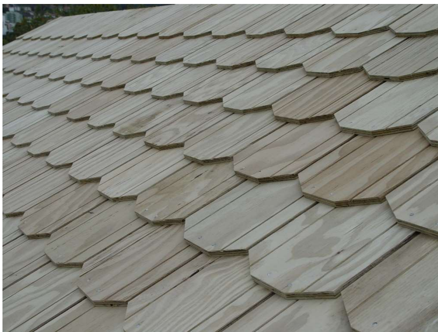
Figura 85 - Aspecto inicial das telhas, quando instaladas no Protótipo
