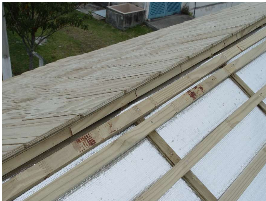
Figura 91 – Região sob as telhas onde pode estar se desenvolvendo agentes biodeterioradores da madeira
