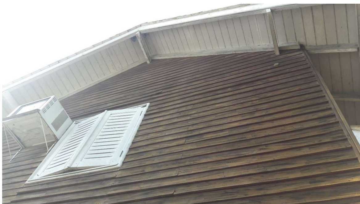
Figura 59 - Região da fachada lateral no momento da inspeção
