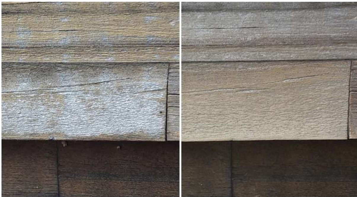
Figura 69 - Siding pré e pós lixação
