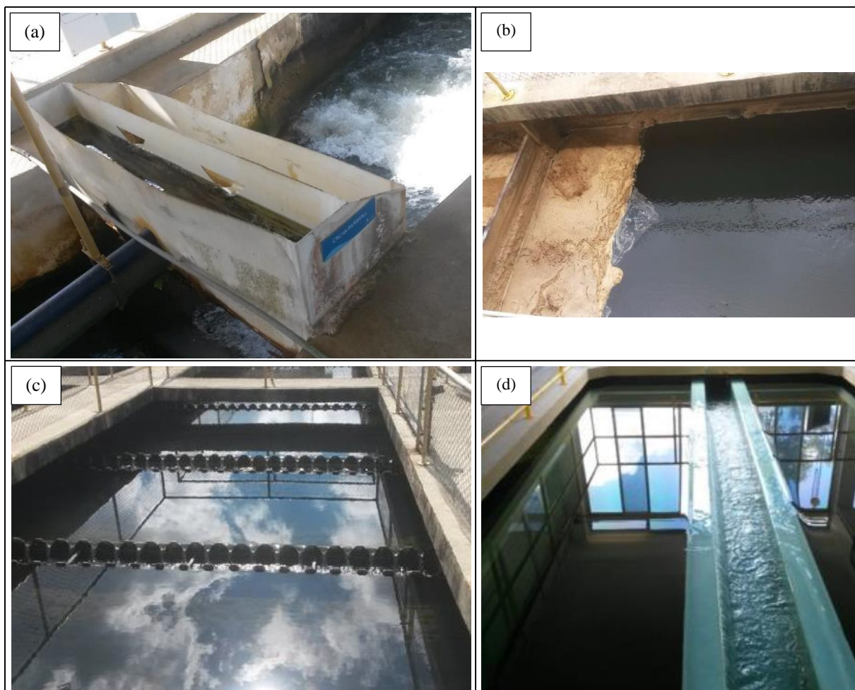
Figura 4 – a) Calha Parshall com unidade de mistura rápida; b) Floculador hidráulico; c) Decantadores de alta taxa com placas de PVC; d) “Filtro russo”; e) Prensa parafuso.
