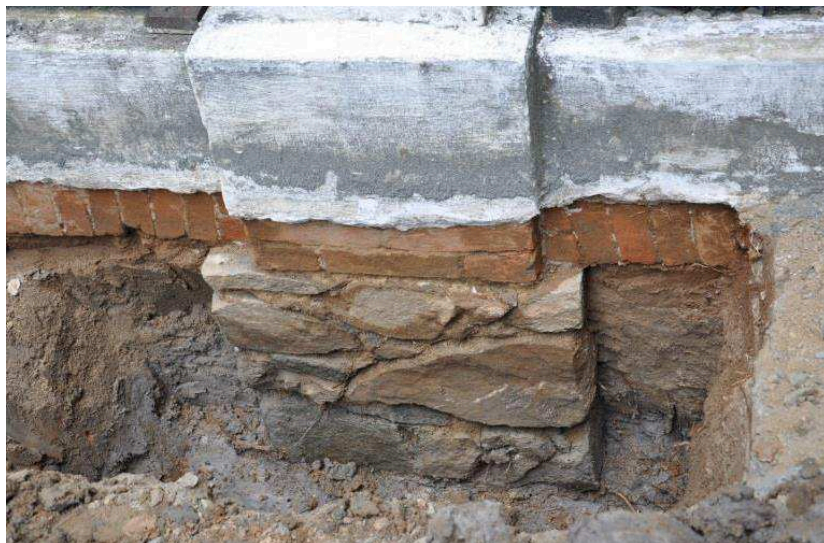
Figura 3 - Vista da fundação em pedra de um dos pilares da varanda do térreo
