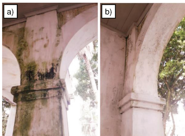
Figura 38 - Manifestação de bolor: (a) no ponto B2; (b) no ponto B3
