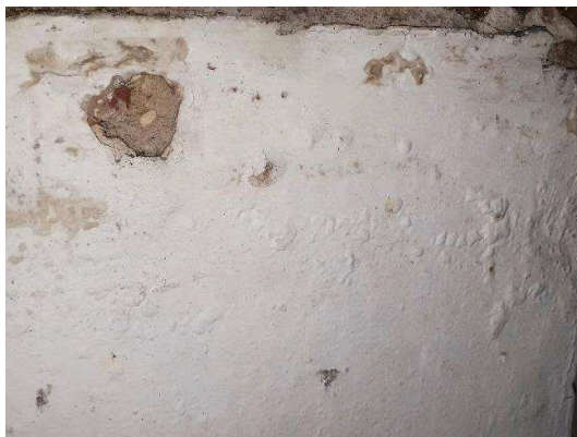
Figura 52 - Vesícula no 3º pavimento
