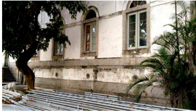
Figura 11 - Uma das fachadas externas do Palácio Universitário da UFRJ, com sinais claros de umidade ascendente
