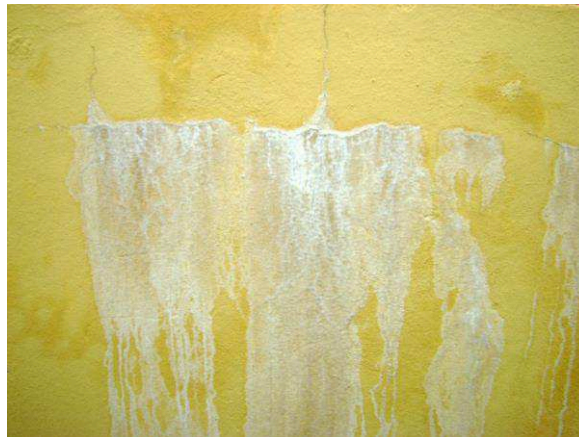
Figura 14 - Eflorescência: cristalização dos sais solúveis na superfície da argamassa
