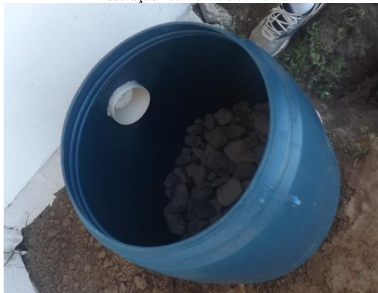
Ilustração 20: Pré-filtro com brita
