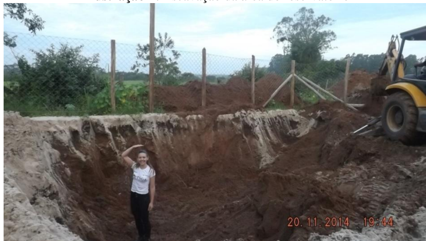
Ilustração 7: Escavação da área do reservatório
