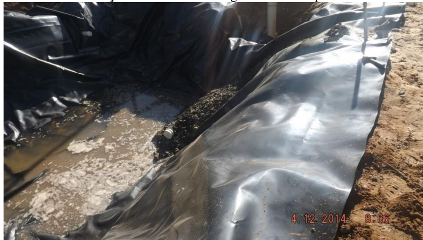
Ilustração 14: Tubo de drenagem envolvido por brita
