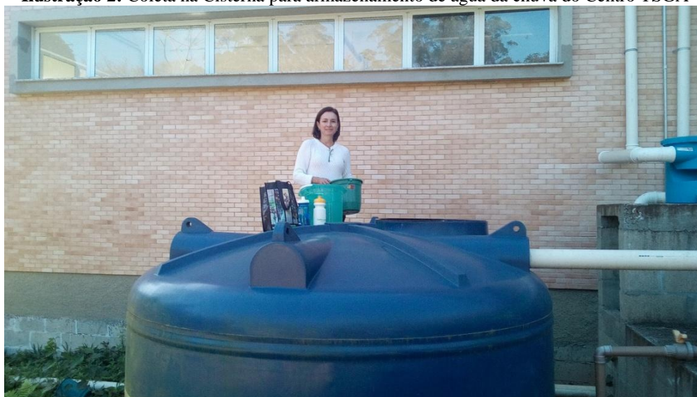
Ilustração 2: Coleta na Cisterna para armazenamento de água da chuva do Centro TSGA
