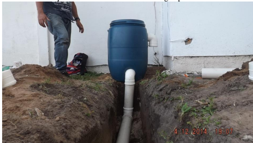
Ilustração 16: Pré-filtro e condutor da água para a cisterna
