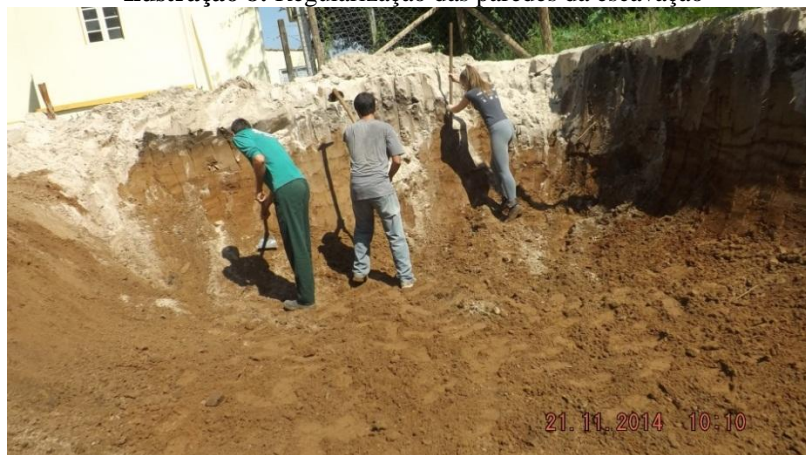
Ilustração 8: Regularização das paredes da escavação
