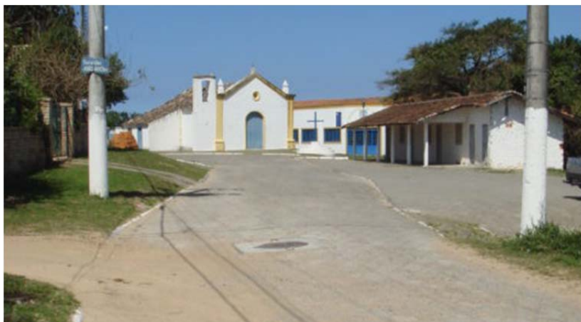
Figura 29 - Vista a partir da Rua da Capela – Igreja de São Sebastião do Campeche.
