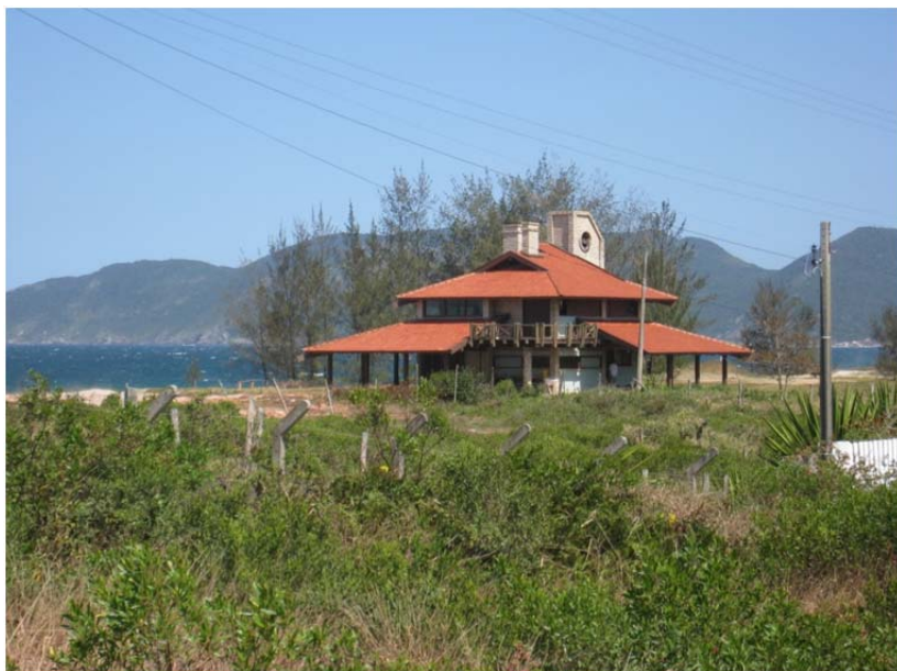
Figura 18 - Avanço da ocupação sobre as dunas – destruição da cobertura vegetal.
