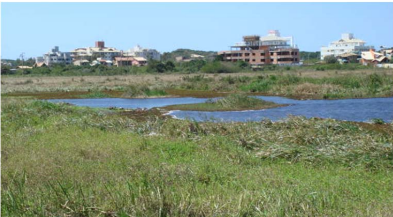
Figura 31 - Vista parcial da Lagoa Pequena e construções em seu entorno.
