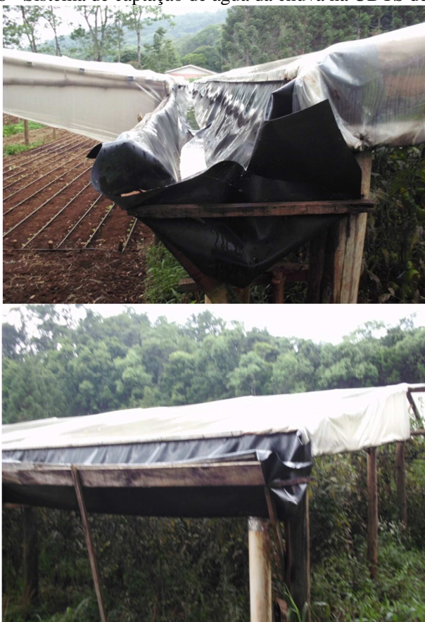
Figura 48 - Sistema de captação de água da chuva na UDTS de Chapecó
