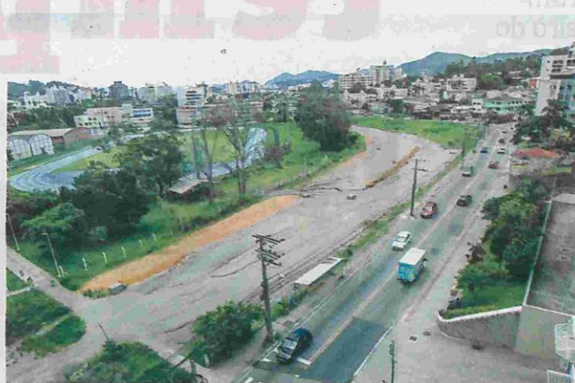
Um trecho tem pista pronta e outro passou por terraplenagem
