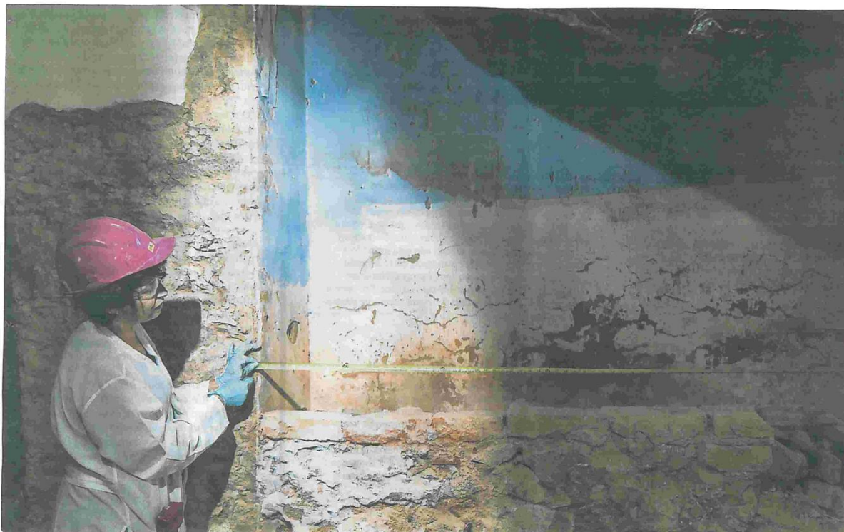
Márcia trabalha para restaurar altar construído no século XIX
