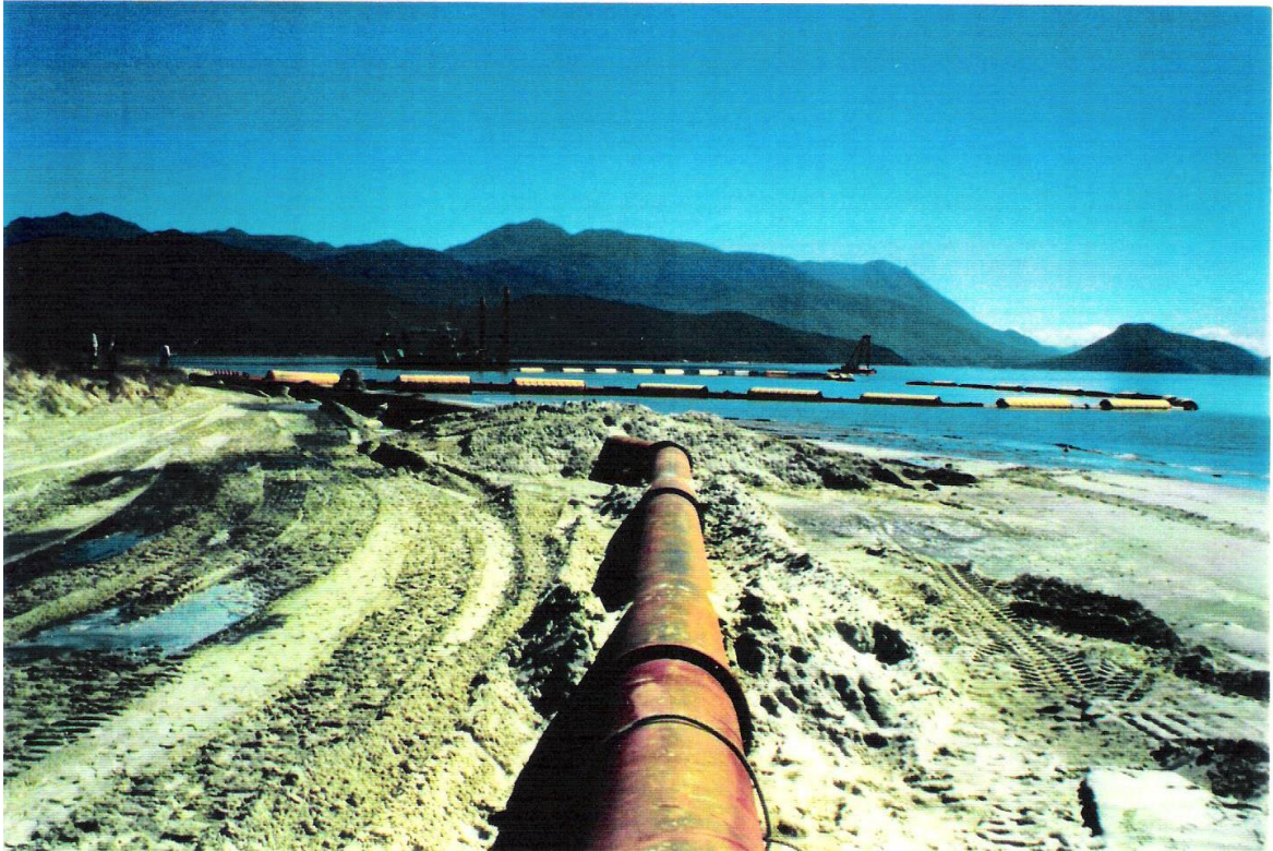
Figura 9 - Execução da obra de dragagem para reconstrução do setor norte da Praia do Sonho.
