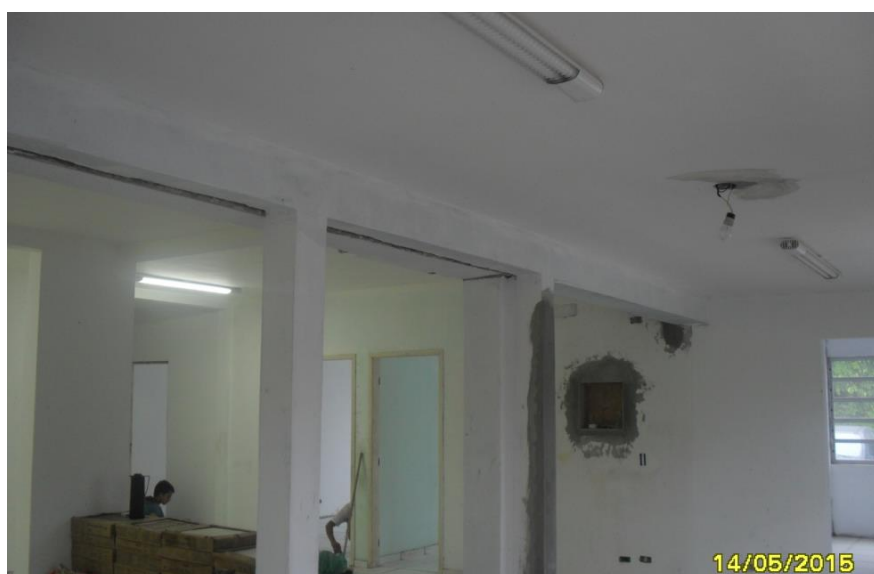
Figura 76 - Pilar nivelado em 2015
