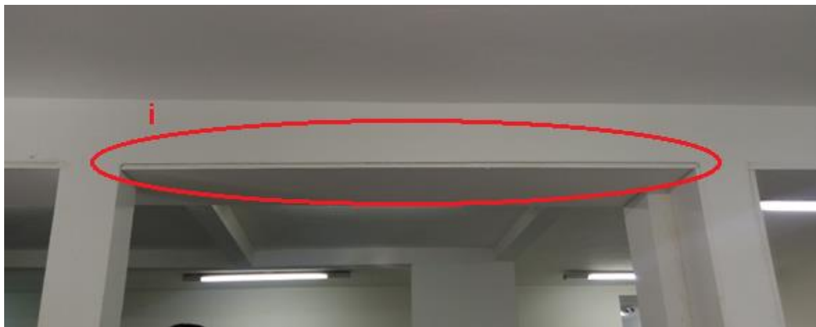
Figura 77 - Junção entre a viga de concreto e a base de madeira realçada no detalhe "i"
