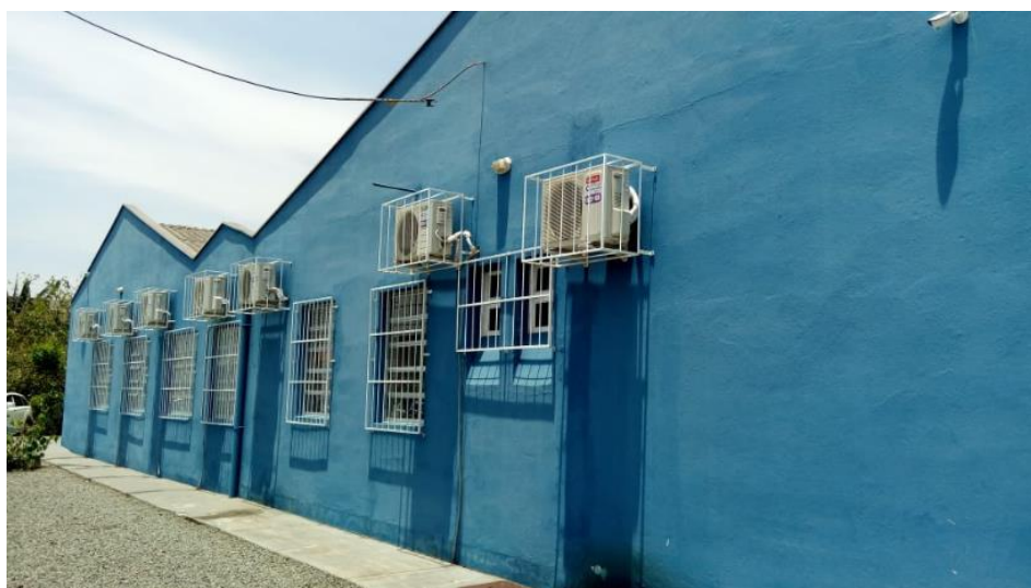
Figura 36 - Vista da lateral esquerda da UBS Costa e Silva
