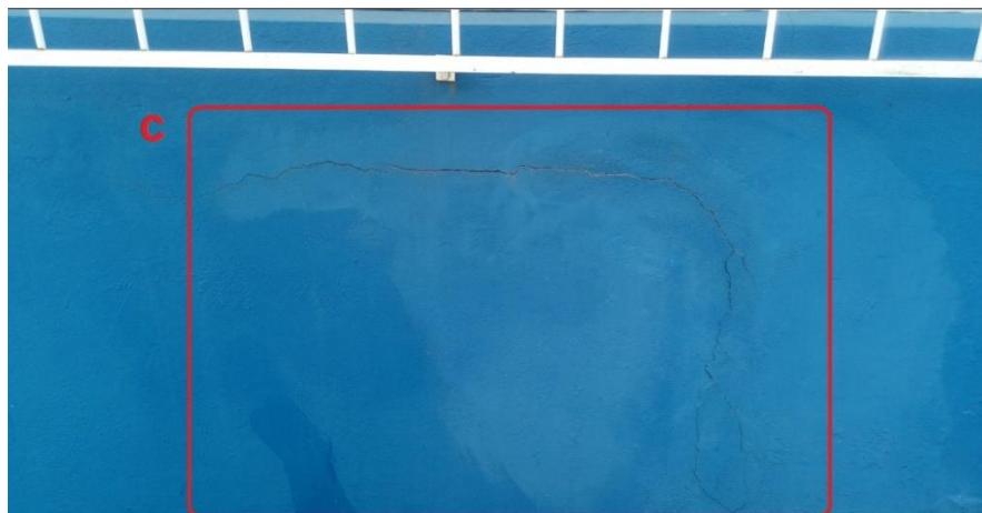
Figura 33 - Fissuras na lateral direita da edificação
