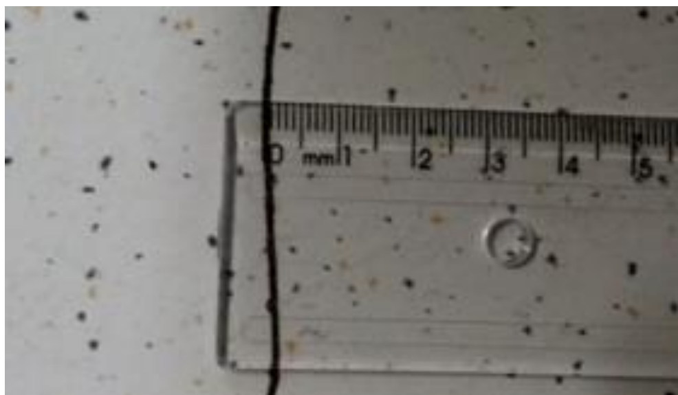
Figura 83 - Medição da abertura da manifestação patológica do detalhe "m"
