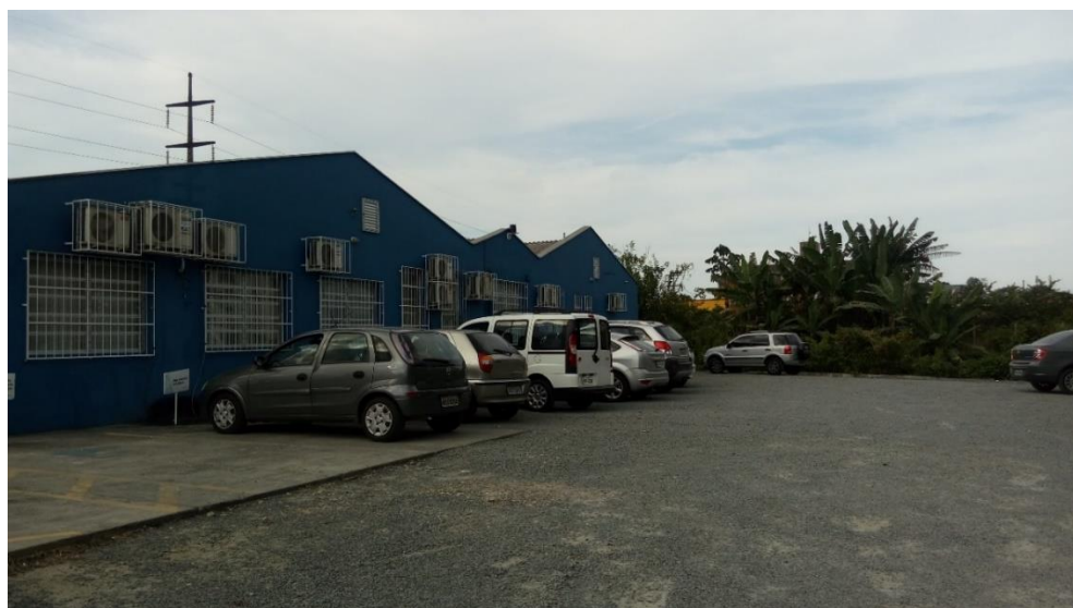
Figura 31 – Vista do estacionamento e da lateral direita da UBS Costa e Silva
