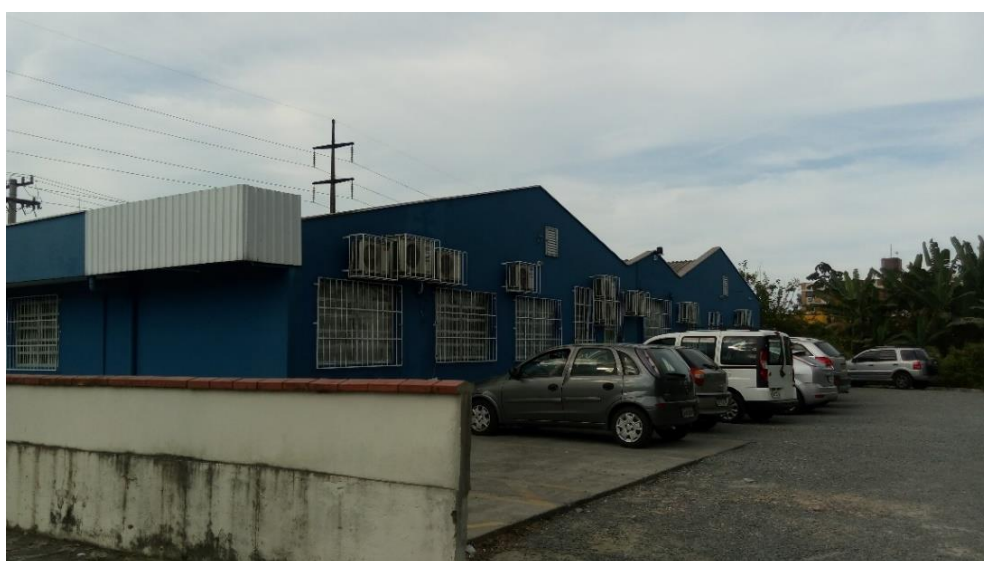
Figura 30 - Vista da lateral direita da UBS Costa e Silva
