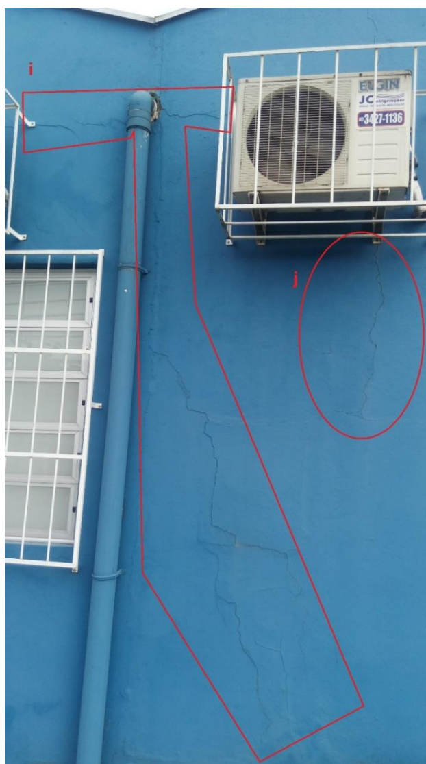
Figura 42 - Fissuras na lateral esquerda da unidade
