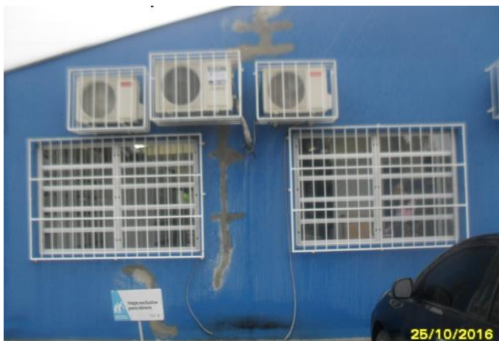
Figura 34 - Correção das fissuras em 2016
