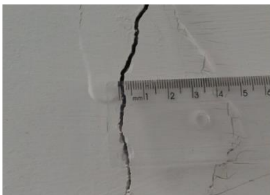
Figura 58 - Medição da abertura da manifestação patológica do detalhe "h"
