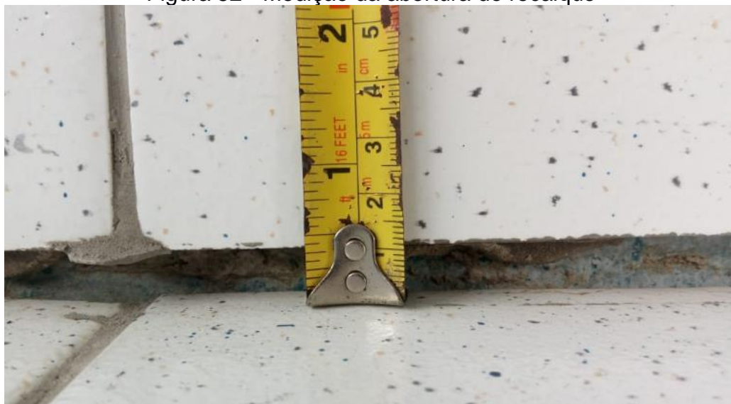
Figura 52 - Medição da abertura do recalque
