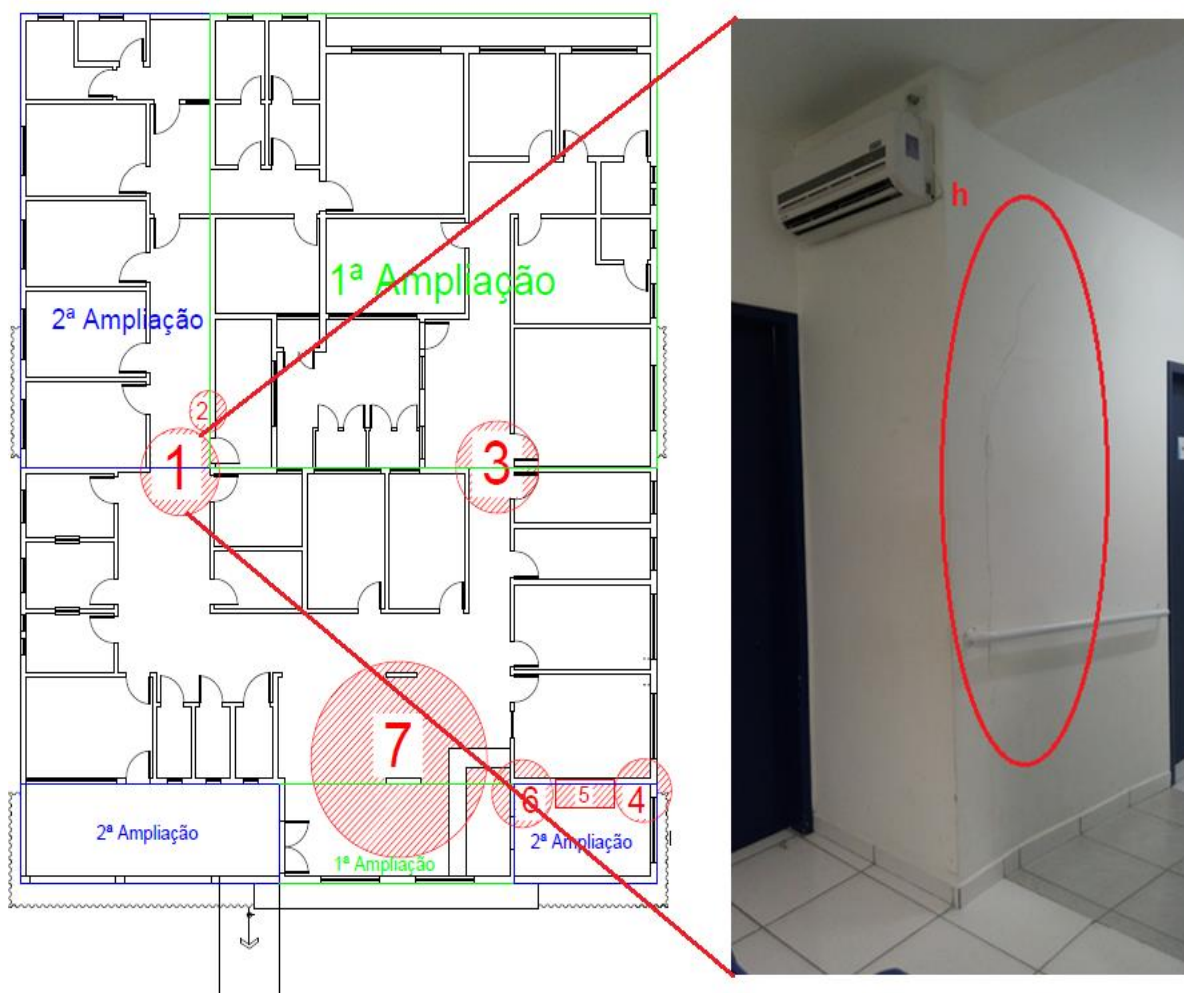
Figura 56 - Relação entre projeto e área com fissura conforme círculo 1
