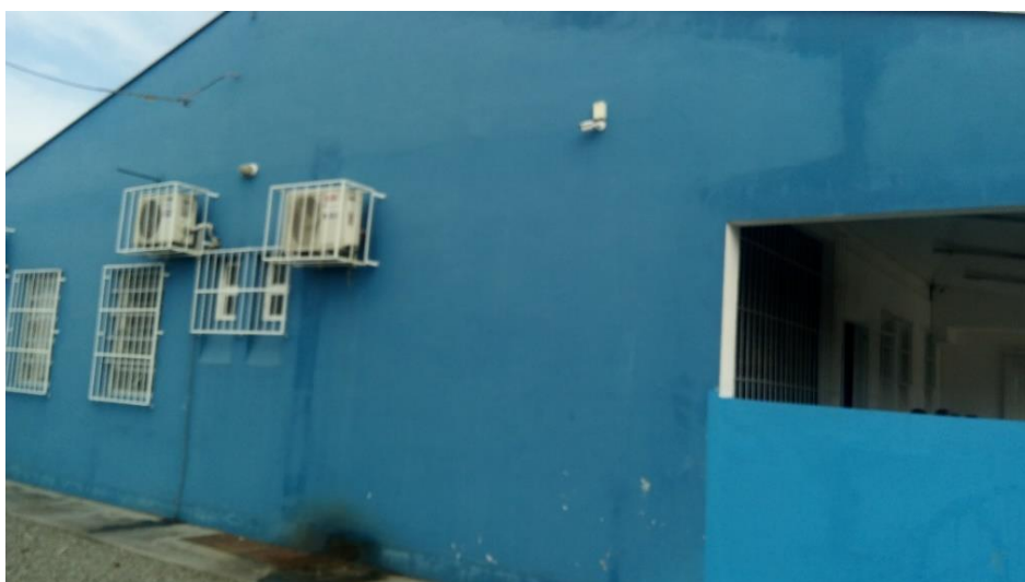
Figura 35 - Vista da lateral esquerda da UBS Costa e Silva
