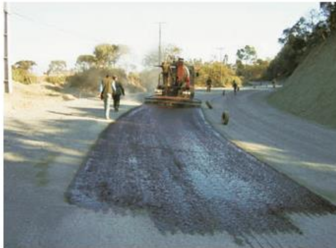
Figura 2.14 - Aplicação de emulsão asfáltica em serviço de imprimação.
