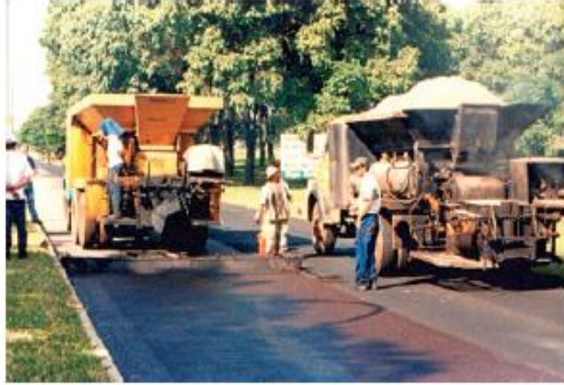
Figura 2.6 - Aplicação de lama asfáltica como manutenção preventiva.
