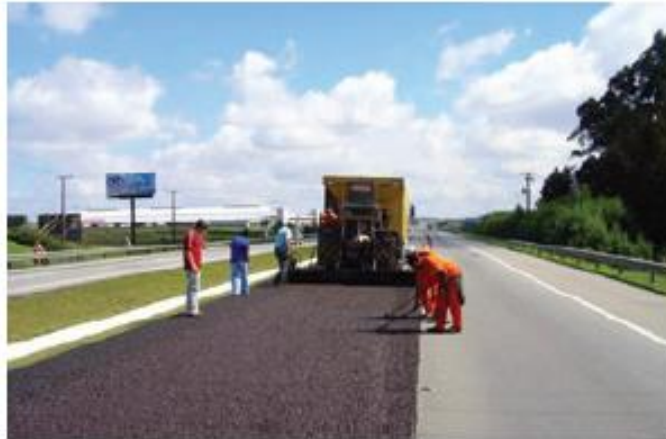
Figura 2.8 - Aplicação de MRAF para melhorar a aderência pneu-pavimento.
