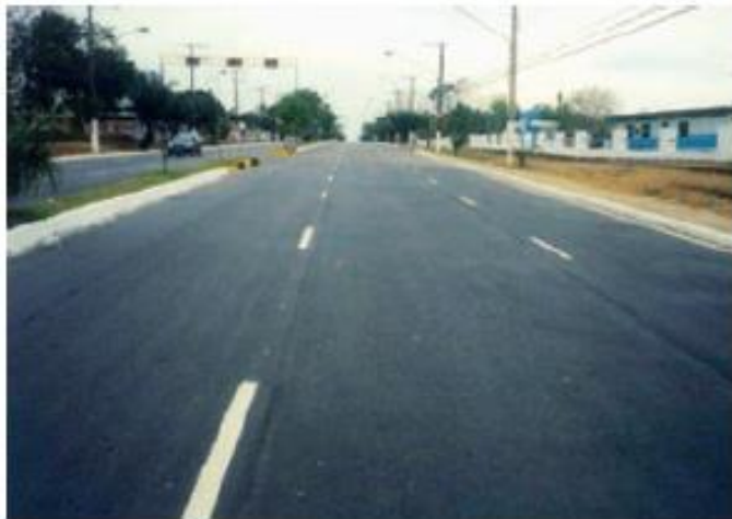
Figura 2.5 - Revestimento areia asfalto a frio em via urbana.
