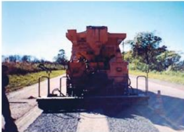
Figura 2.7 - Aplicação de MRAF para enchimento de trilhas de roda.
