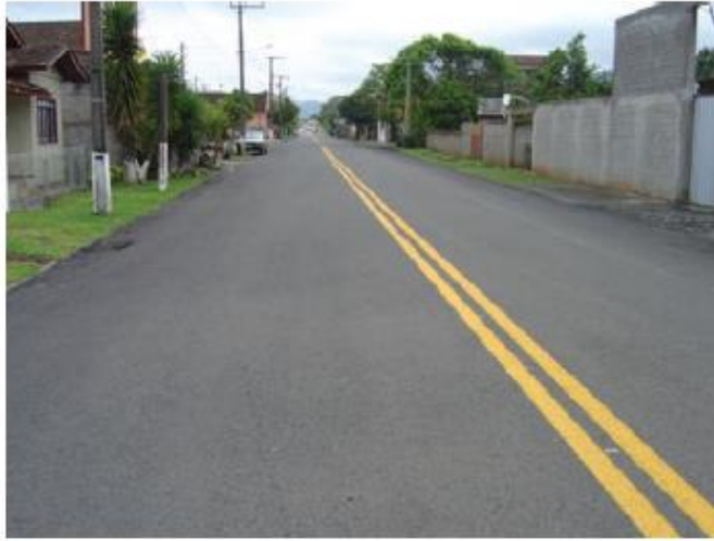
Figura 2.4 - Revestimento asfáltico tipo PMF em via urbana.
