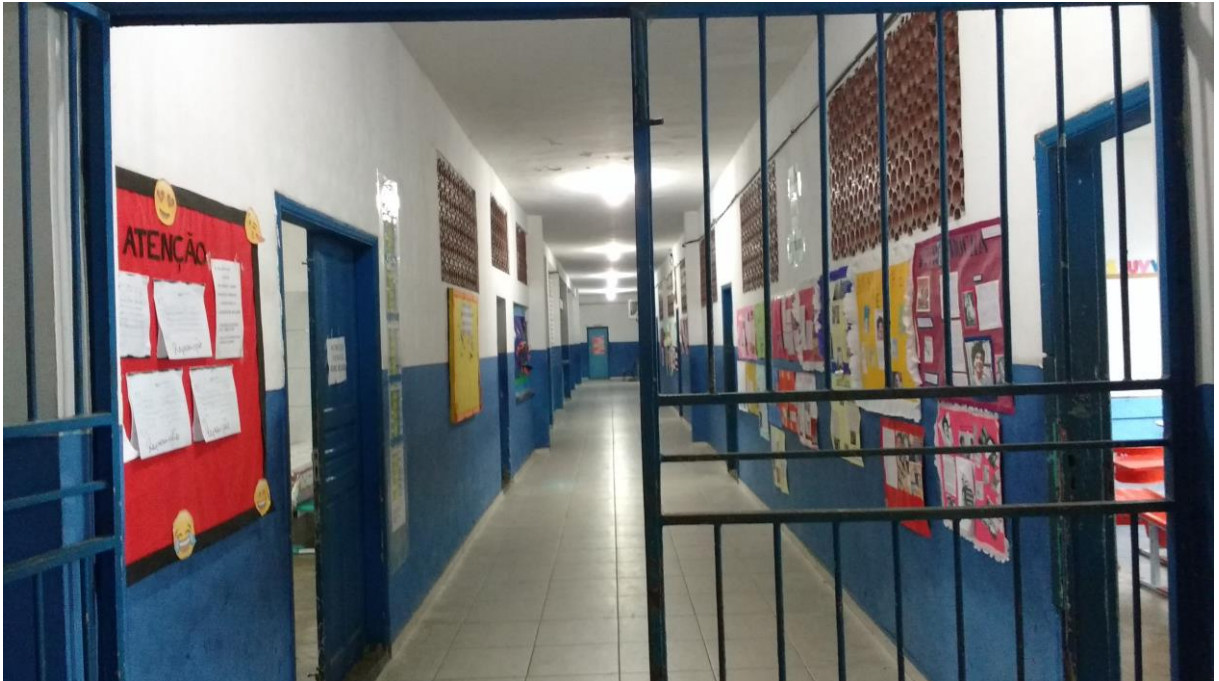
Imagem 5 - Corredor principal da E. M. Santa Luzia. À direita, salas de aula e banheiros dos alunos. À esquerda, refeitório, cozinha e rampa de acesso para outra ala da edificação. Ao fundo, a Sala de Leitura. Outubro, 2017. Fonte: acervo do autor.
