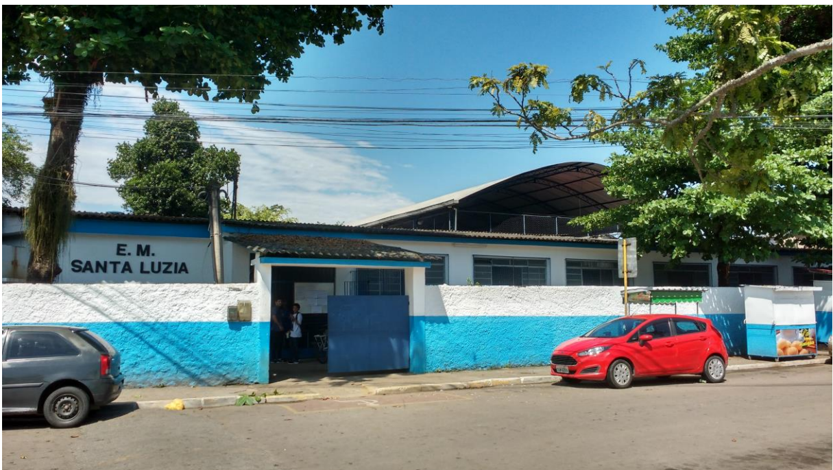
Imagem 4 - Fachada da Escola Municipal Santa Luzia. Nela, não há nada que identifique sua especificidade enquanto polo em Educação Especial e ensino de surdos. Outubro, 2017. Fonte: acervo do autor.
