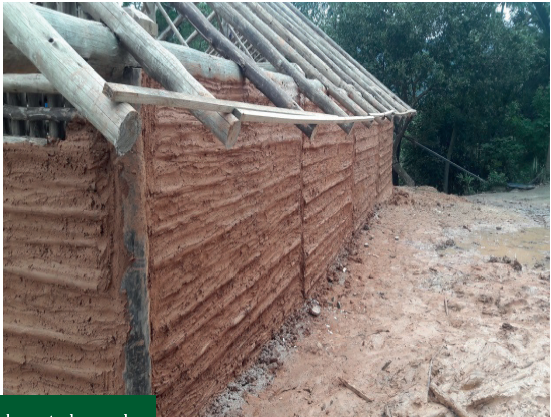
Acabamento das paredes
