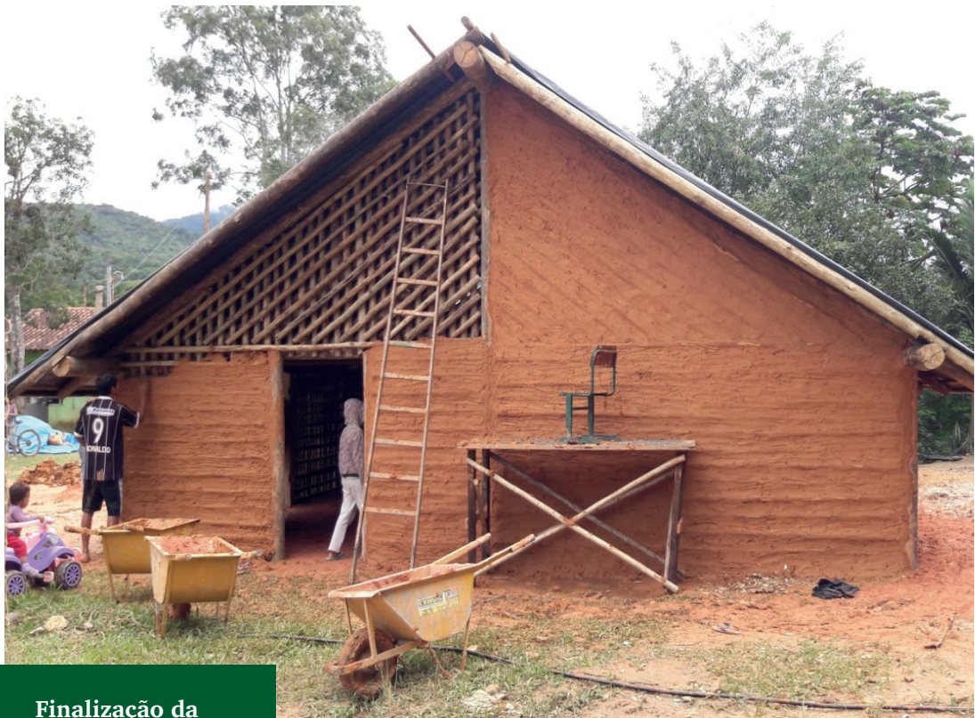
Acabamento das paredes
