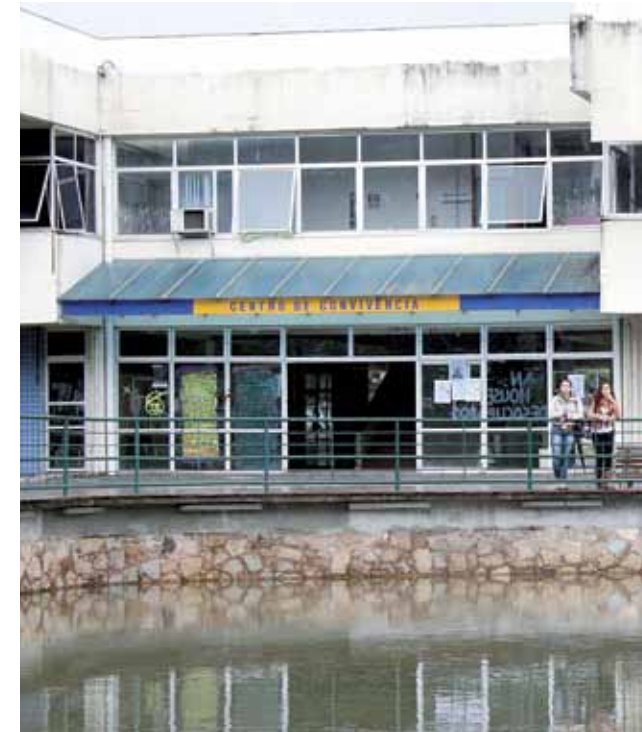
Reforma faz parte do programa de humanização do campus
