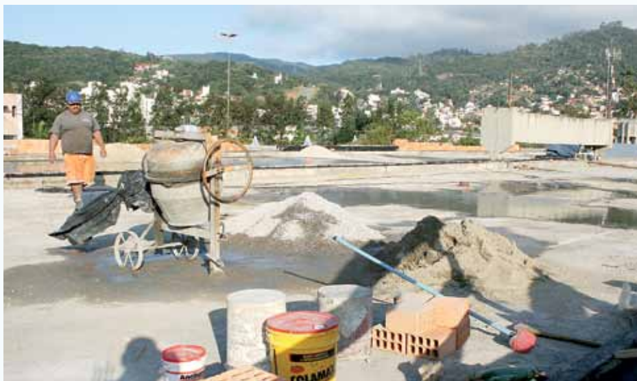
Sem a reforma do telhado, as obras do espaço interno não podiam ter início
