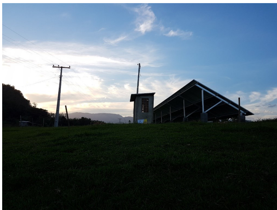
Figura 19 – Sistema construído (LEENERGY, 2017).
