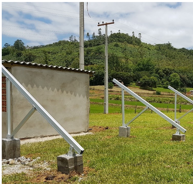
Figura 27 – Fundação, estrutura metálica de fixação e casa do inversor (LENERGY, 2017).
