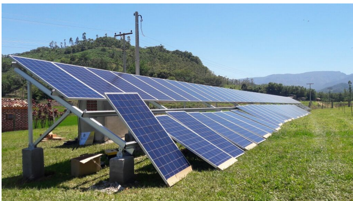
Figura 28 – Disposição e instalação dos 82 módulos fotovoltaicos (LENERGY, 2017).
