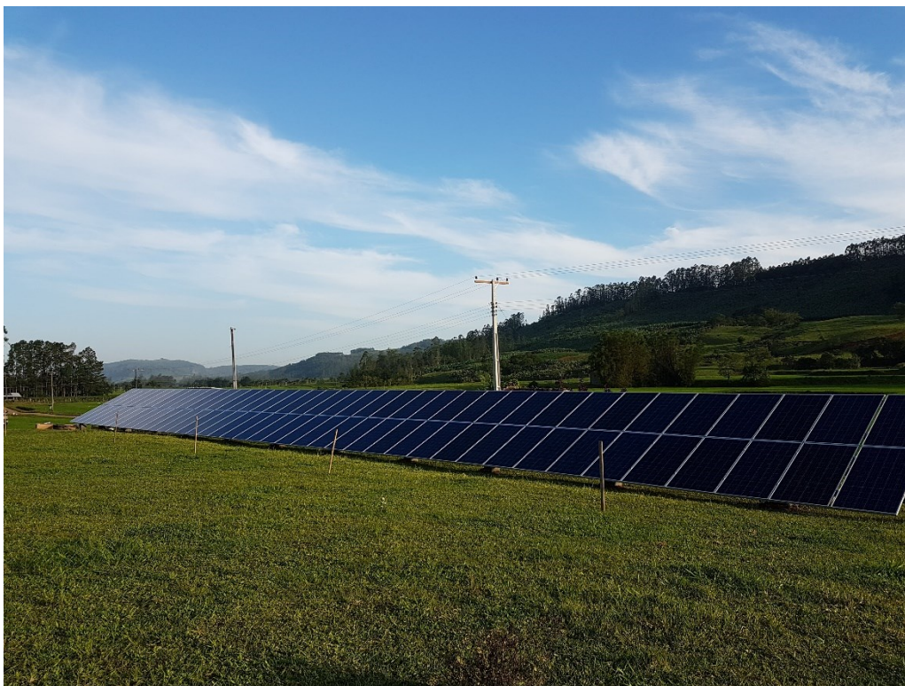
Figura 11 – Sistema fotovoltaico de 26,65 kWp (AUTOR, 2018).
