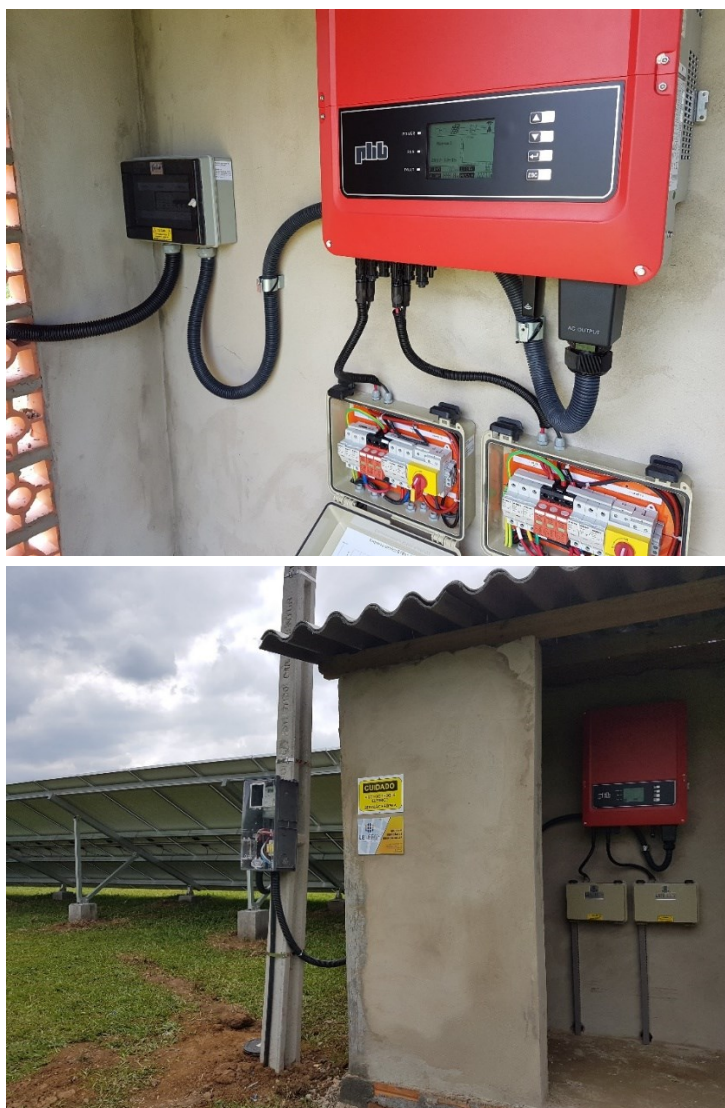
Figura 31 – Parte interna e externa da casa do inversor (LENERGY, 2017).
