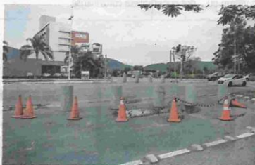
Acesso está fechado com cones e tubos de concreto
